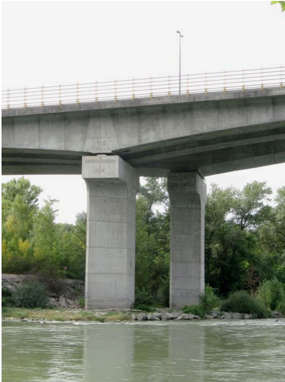
Piles, face amont (depuis la rive gauche)
