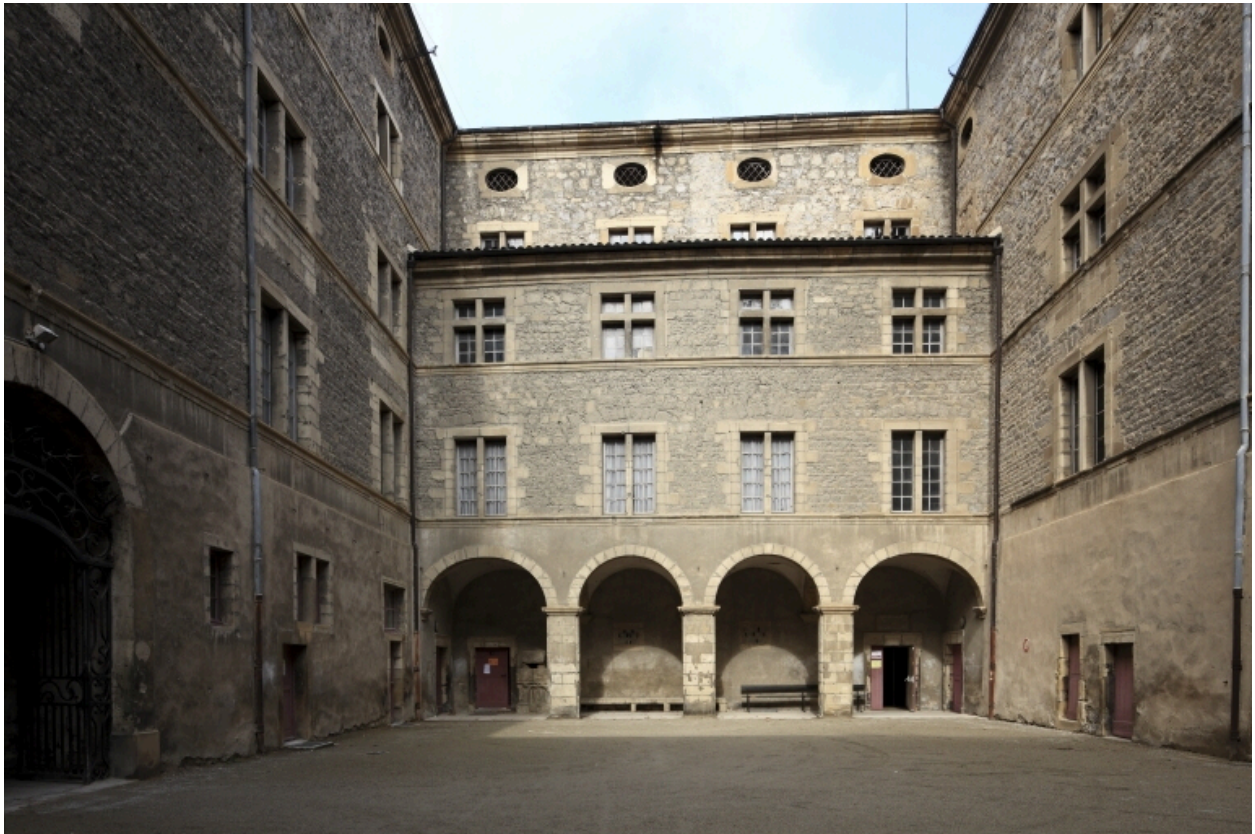
Bâtiment A. Cour d'honneur, élévation nord.
