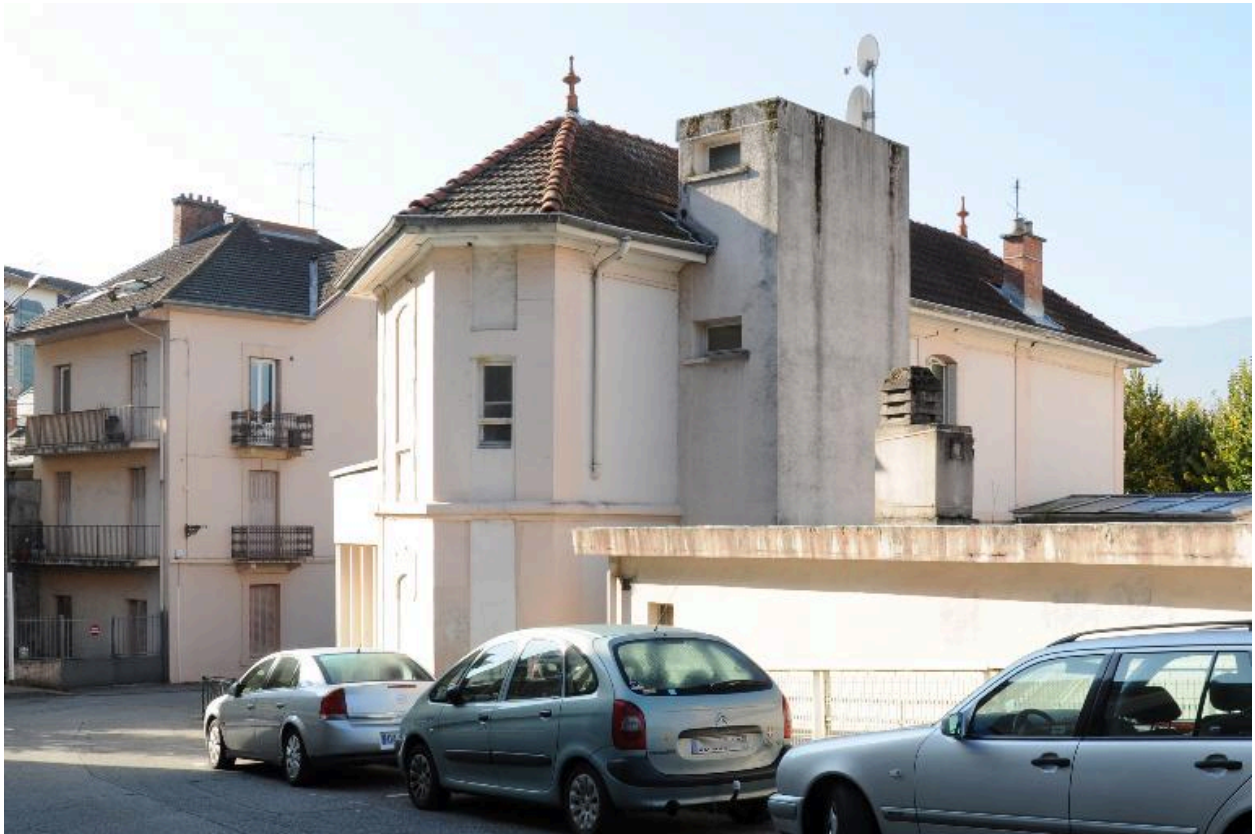
Vue depuis l'arrière
