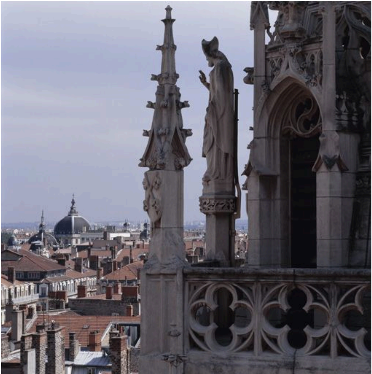
Tour sud, terrasse à la base de la flèche, détail de l'angle nord-est
