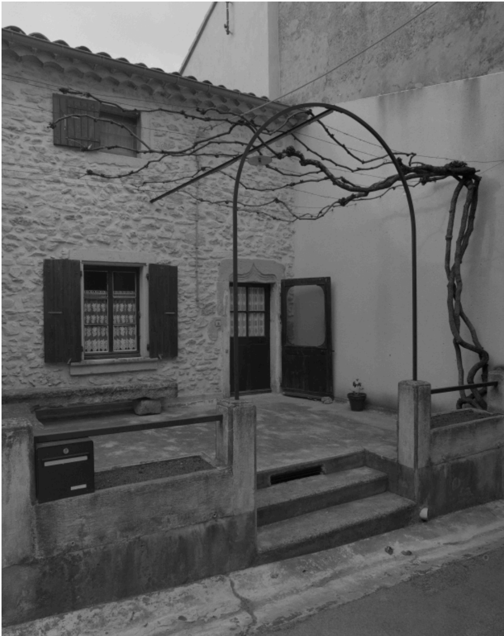
Le Pègue, Grand'ru. Maison (B3 682). Façade sur la Grand'ru, vue partielle.
