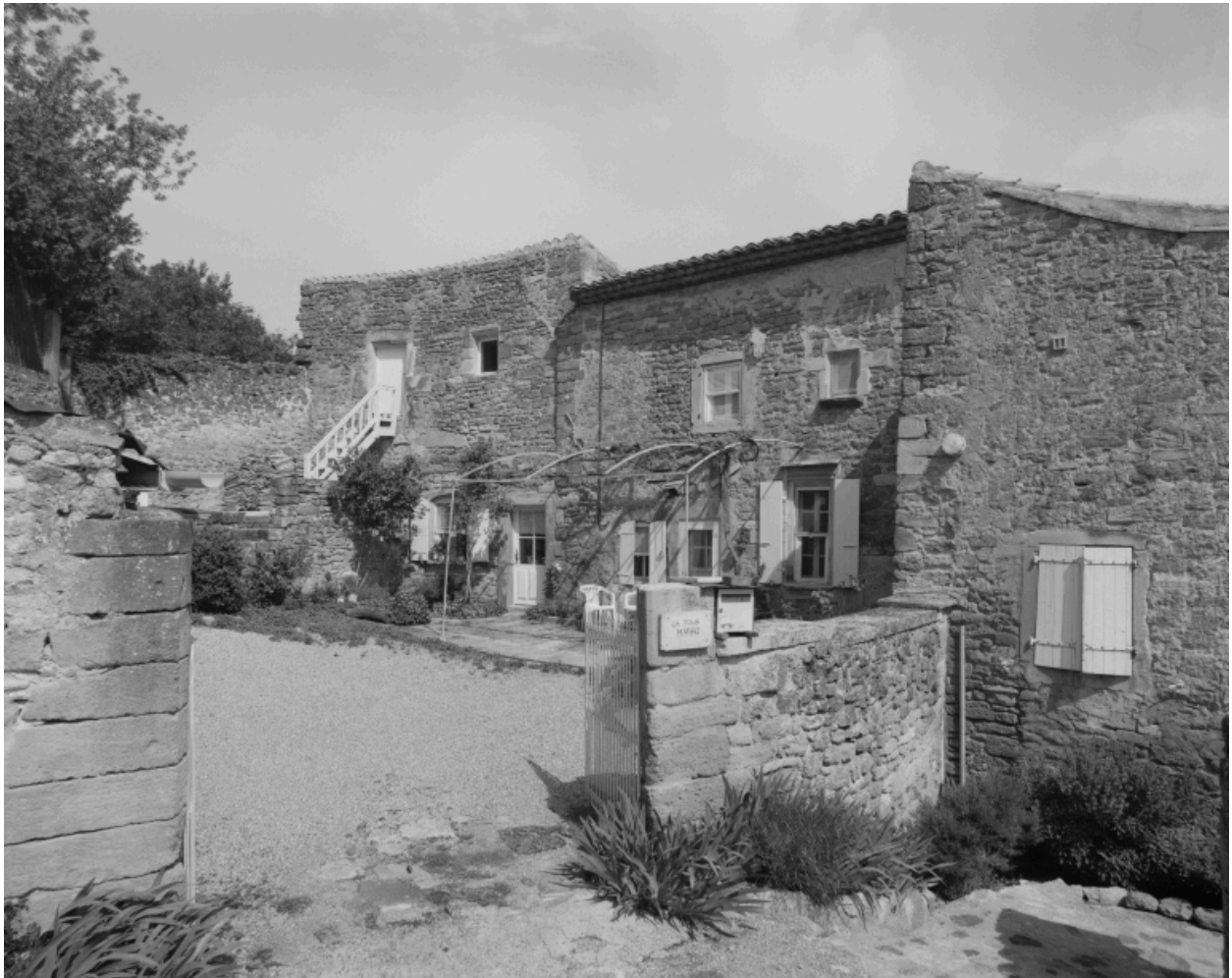
Vue générale de la maison construite contre l'enceinte.
