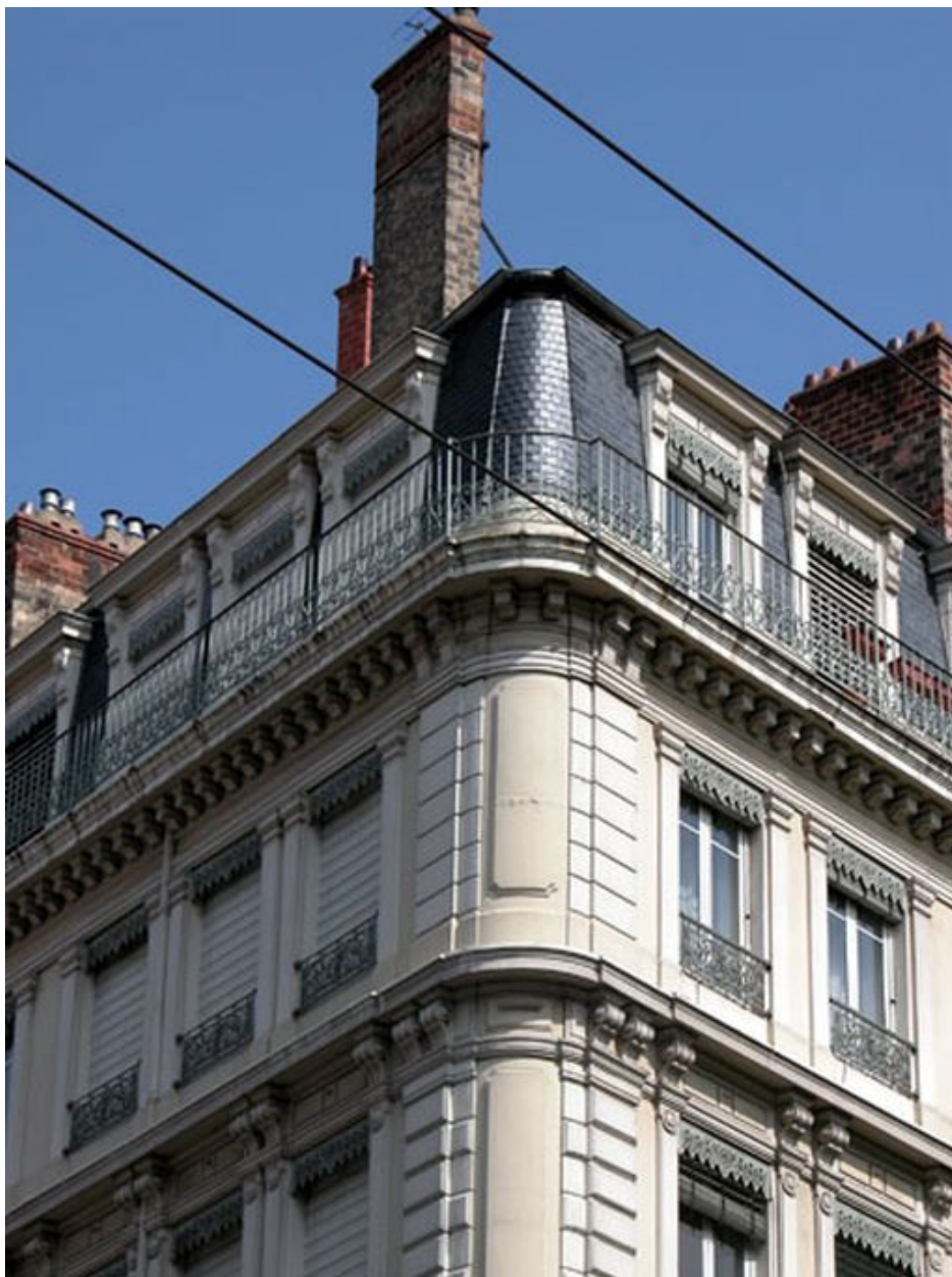
Détail de l'angle avenue Jean-Jaurès - grande rue de la Guillotière
