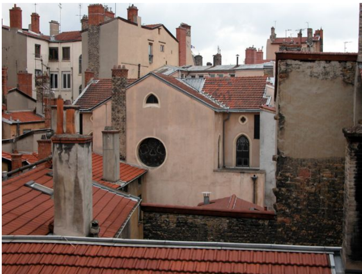
Eglise, vue générale des élévations arrières
