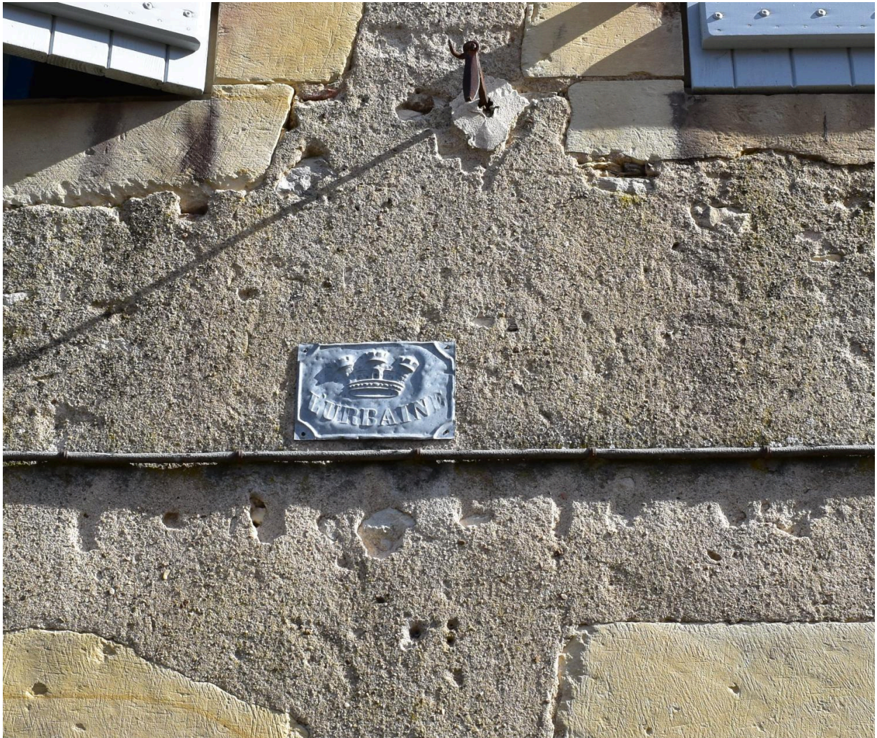
Maison, 12, rue d'Allier, parcelle cadastrale B01 : 1132. Vue générale de la façade sur rue, limite du 18e siècle et 19e siècle. Détail de plaque en tôle estampée de la "compagnie anonyme d'assurances contre l'incendie" l'Urbaine.
