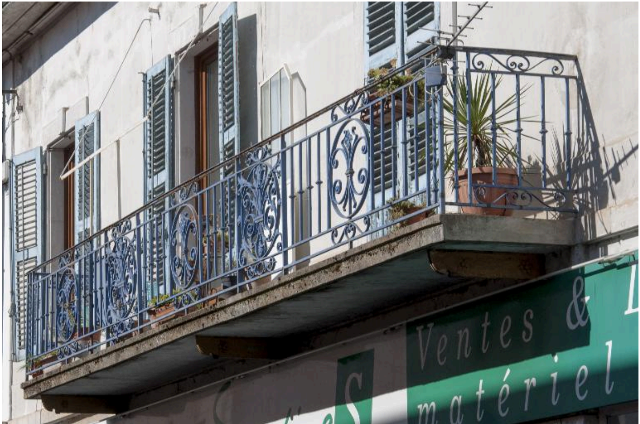
Garde-corps en fer forgé du balcon du 1er étage
