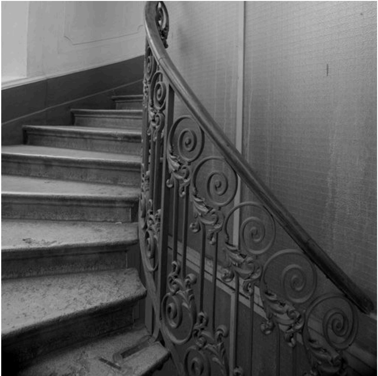
Escalier principal, détail de la rampe
