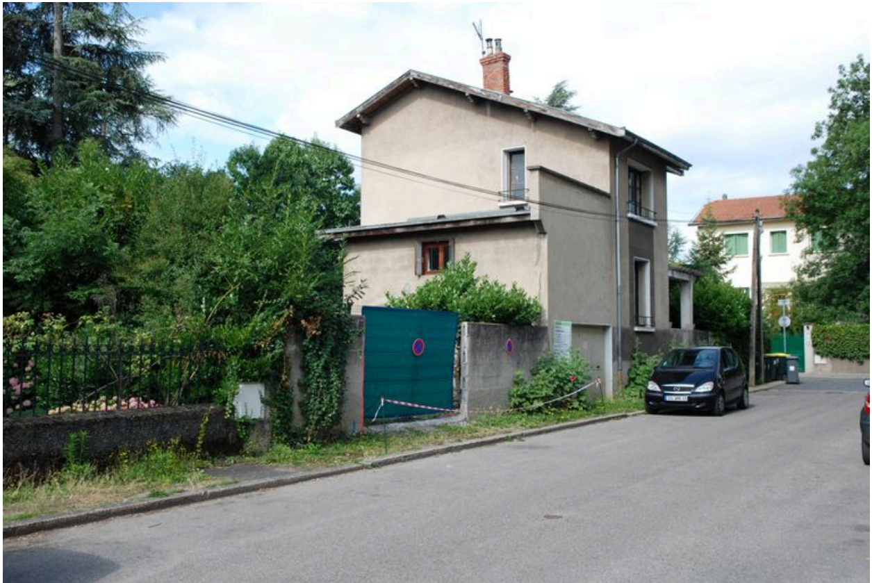
Vue générale des élévations nord et est, depuis l'impasse Chomel.
