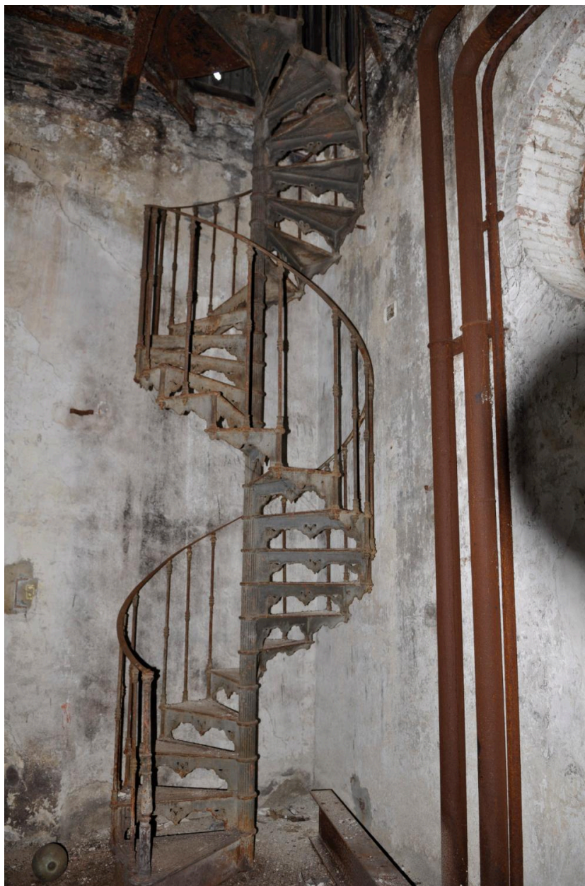
Escalier technique métallique en colimaçon (distillerie).
