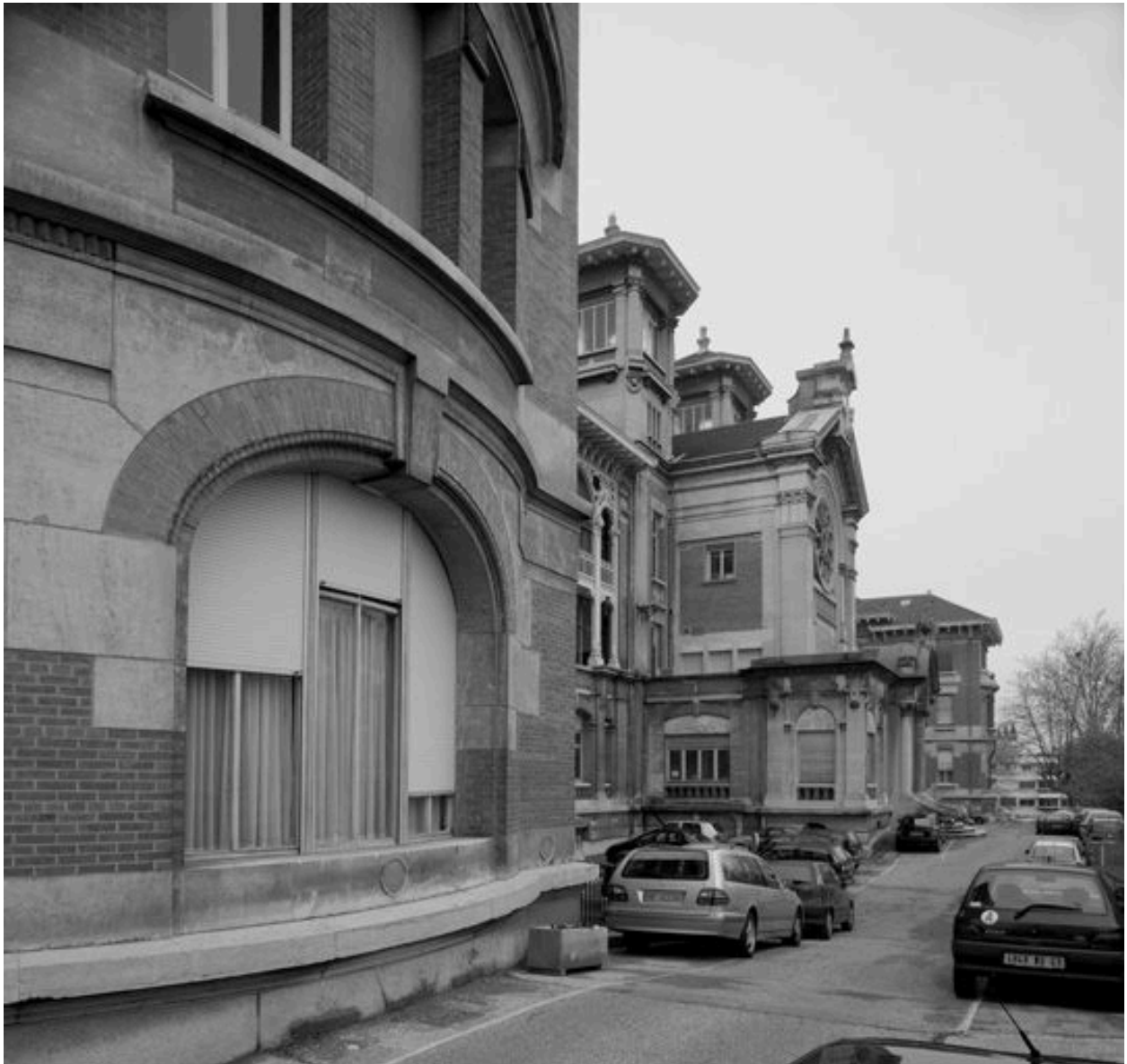
Bâtiment B, façade principale, partie centrale et retours
