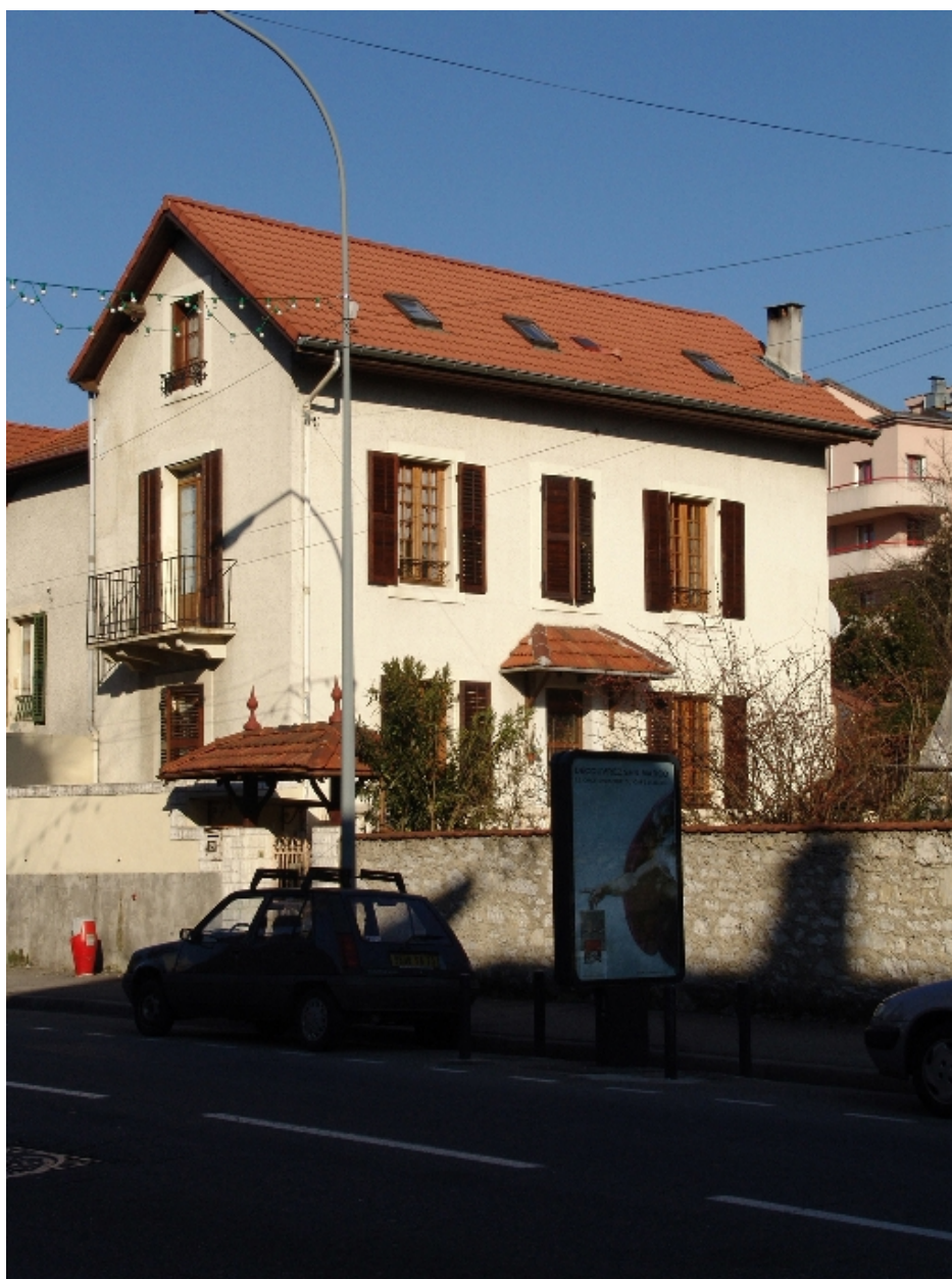
Vue générale prise depuis la rue
