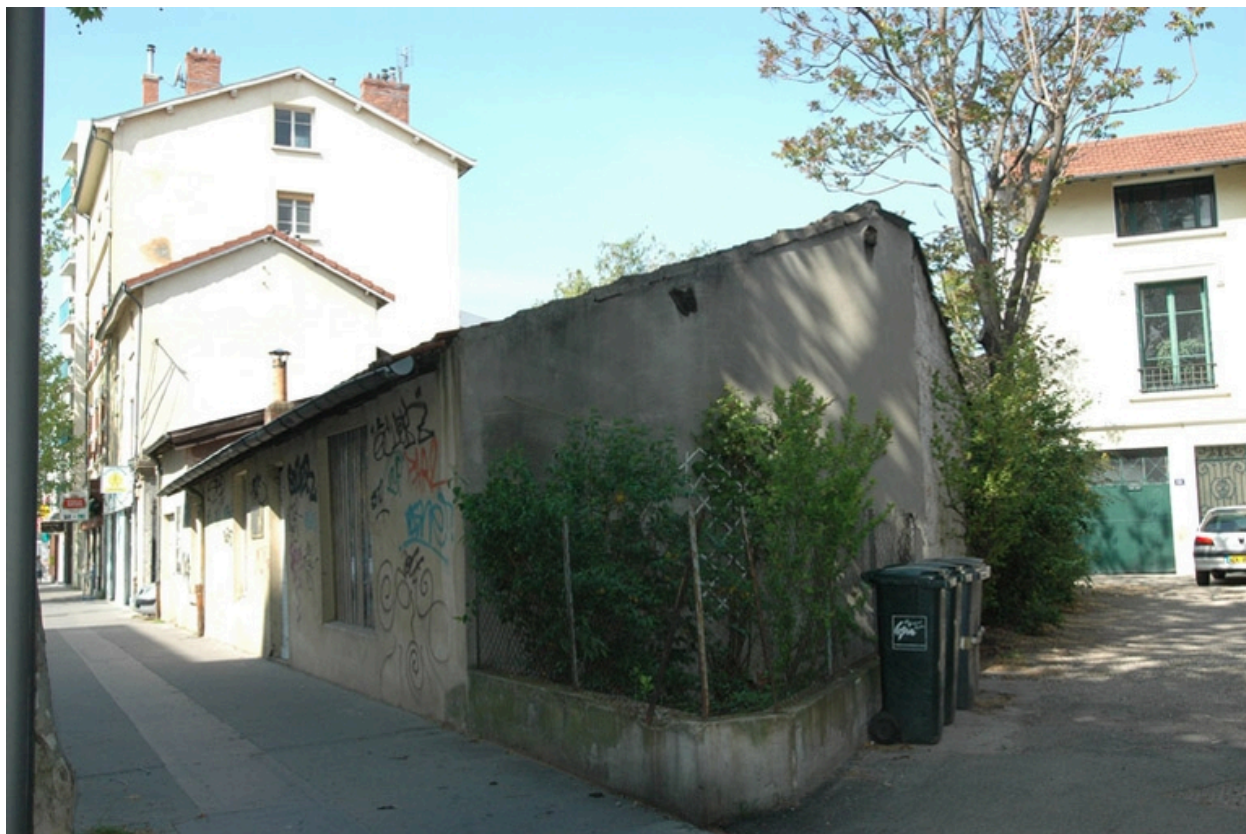
Vue générale, façade principale et angle est.
