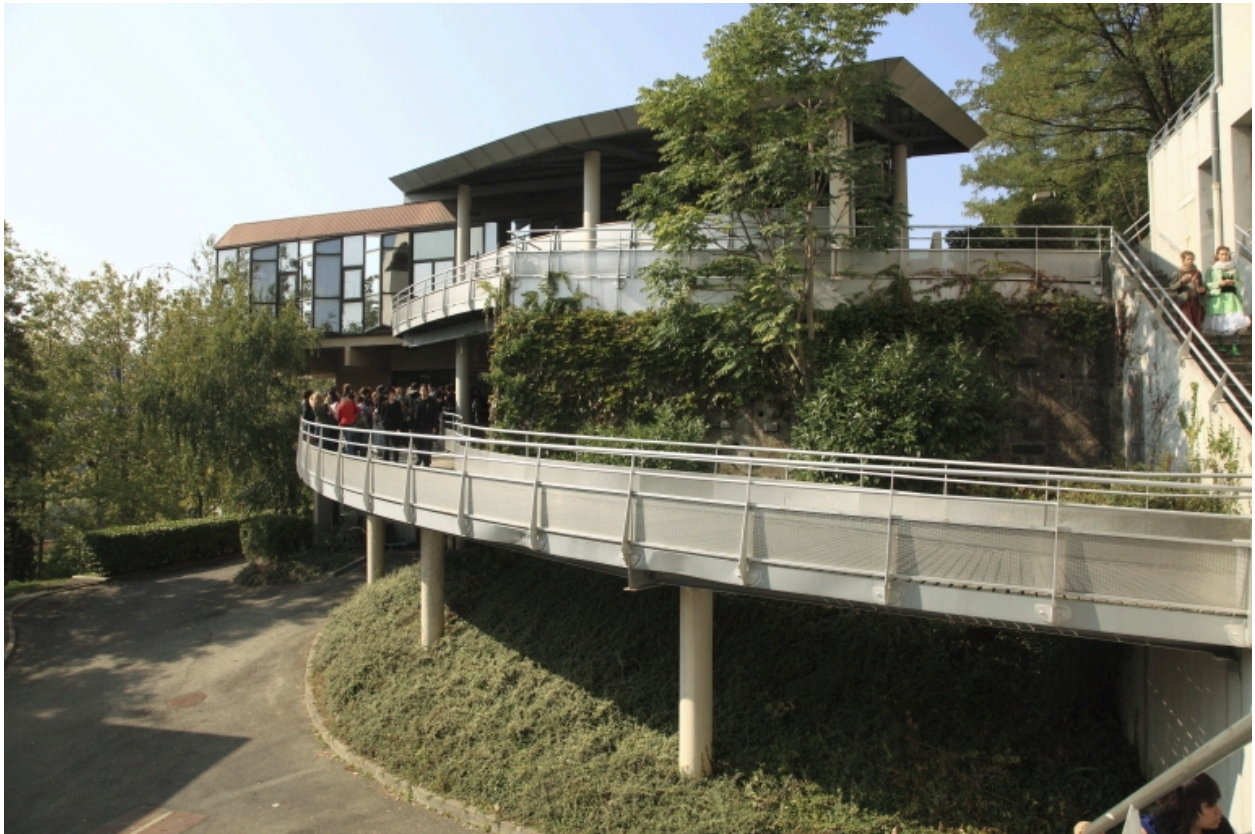
Vue extérieure du restaurant scolaire et sa rampe d'accès.
