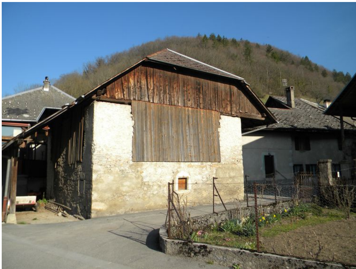
Vue du pignon est de la grange-étable.
