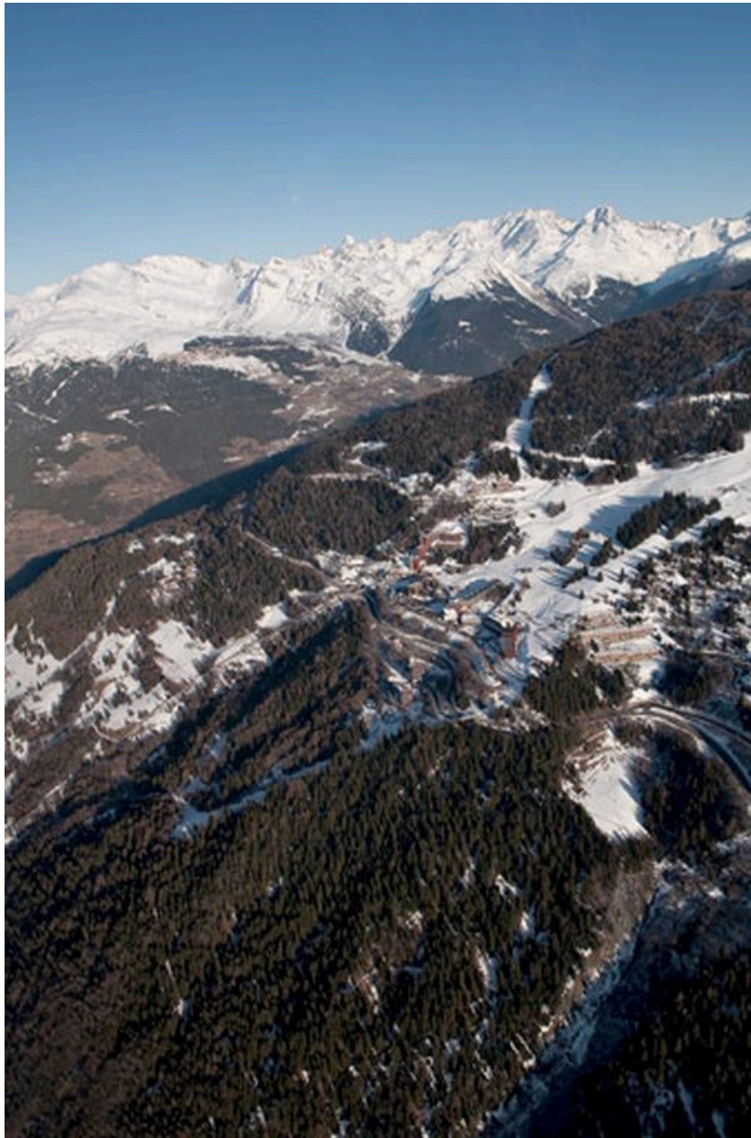
Vue aérienne depuis le sud-ouest. Le site d'Arc 1600
