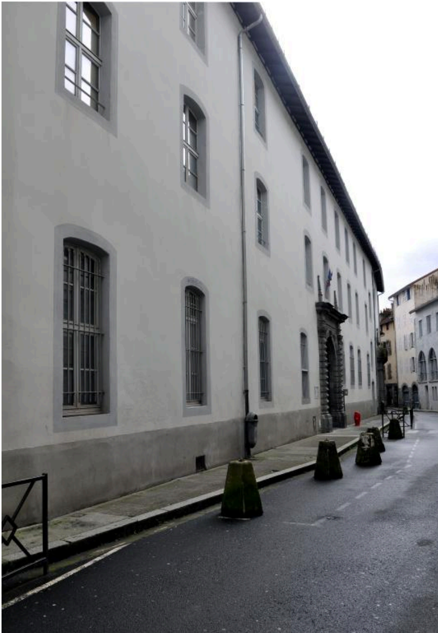
Elévation principale : vue partielle depuis le nord
