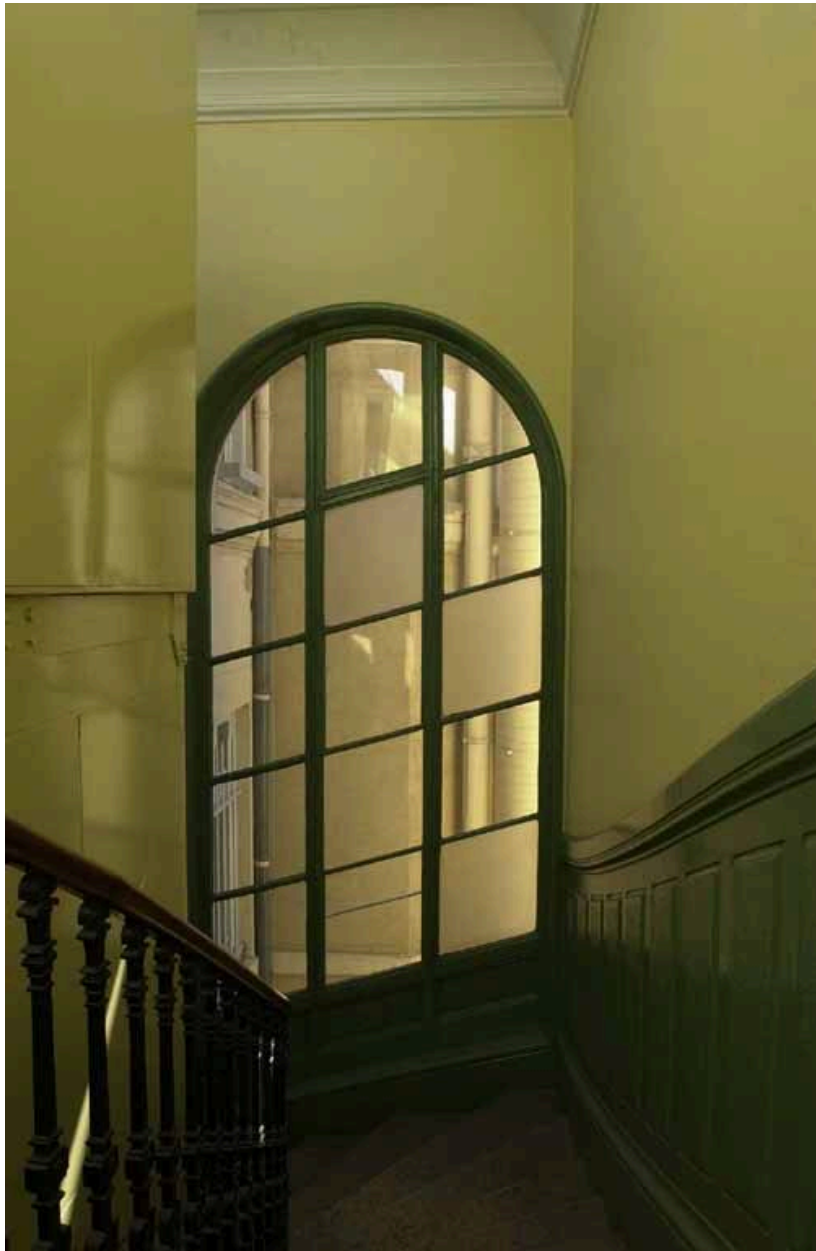
La cage d'escalier au dernier étage carré
