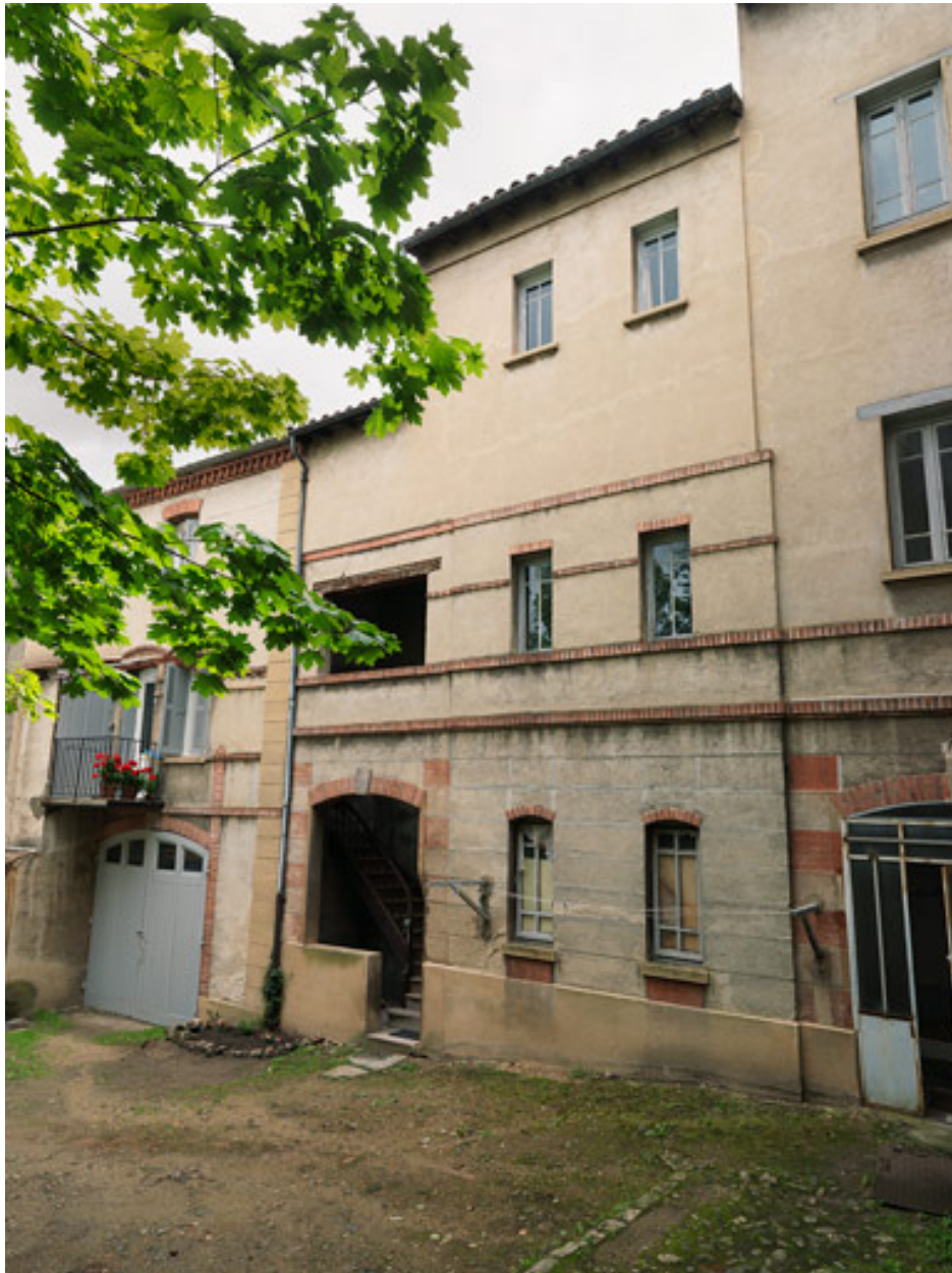
Vue partielle de la cour.
