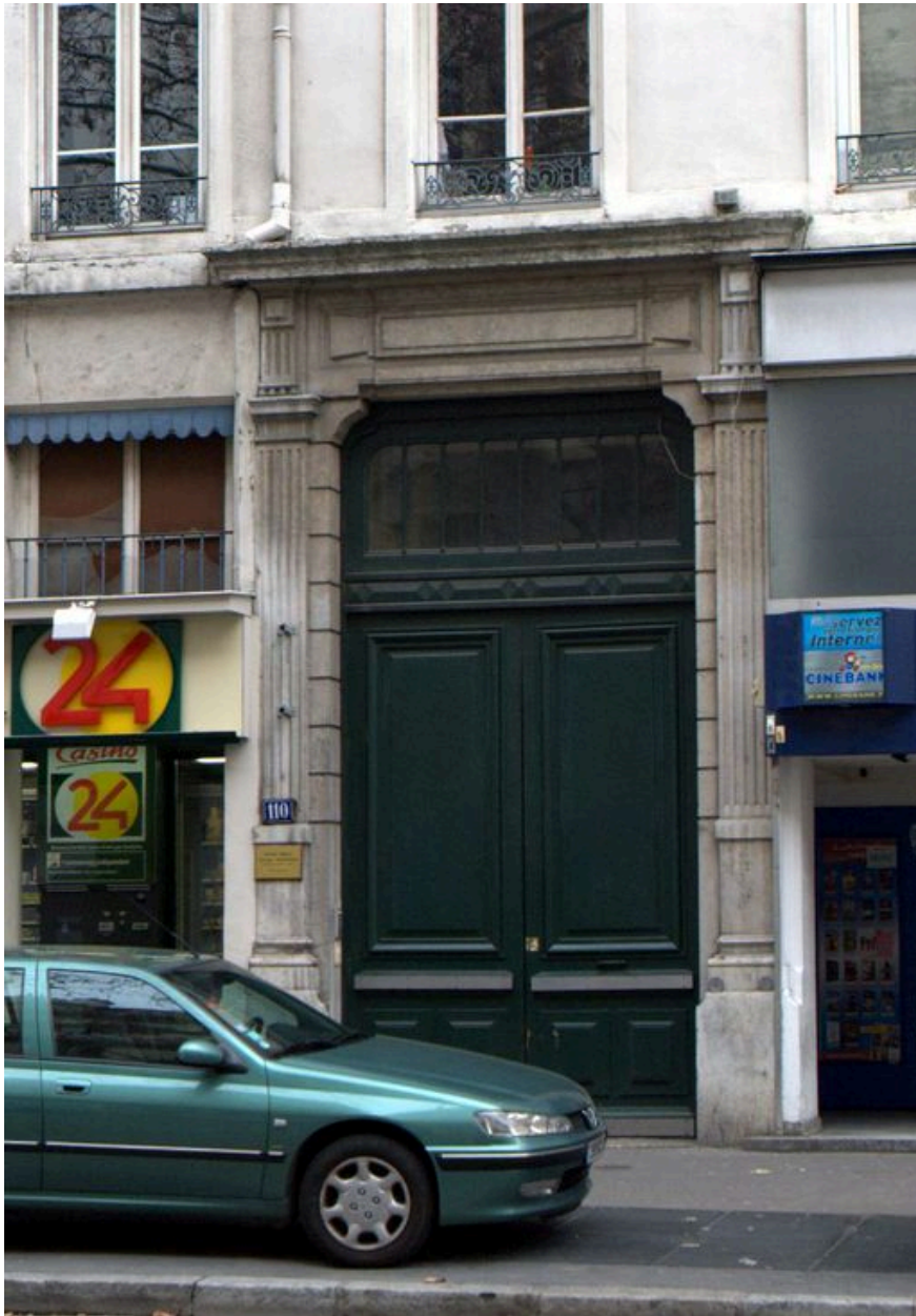
Détail du portail d'entrée
