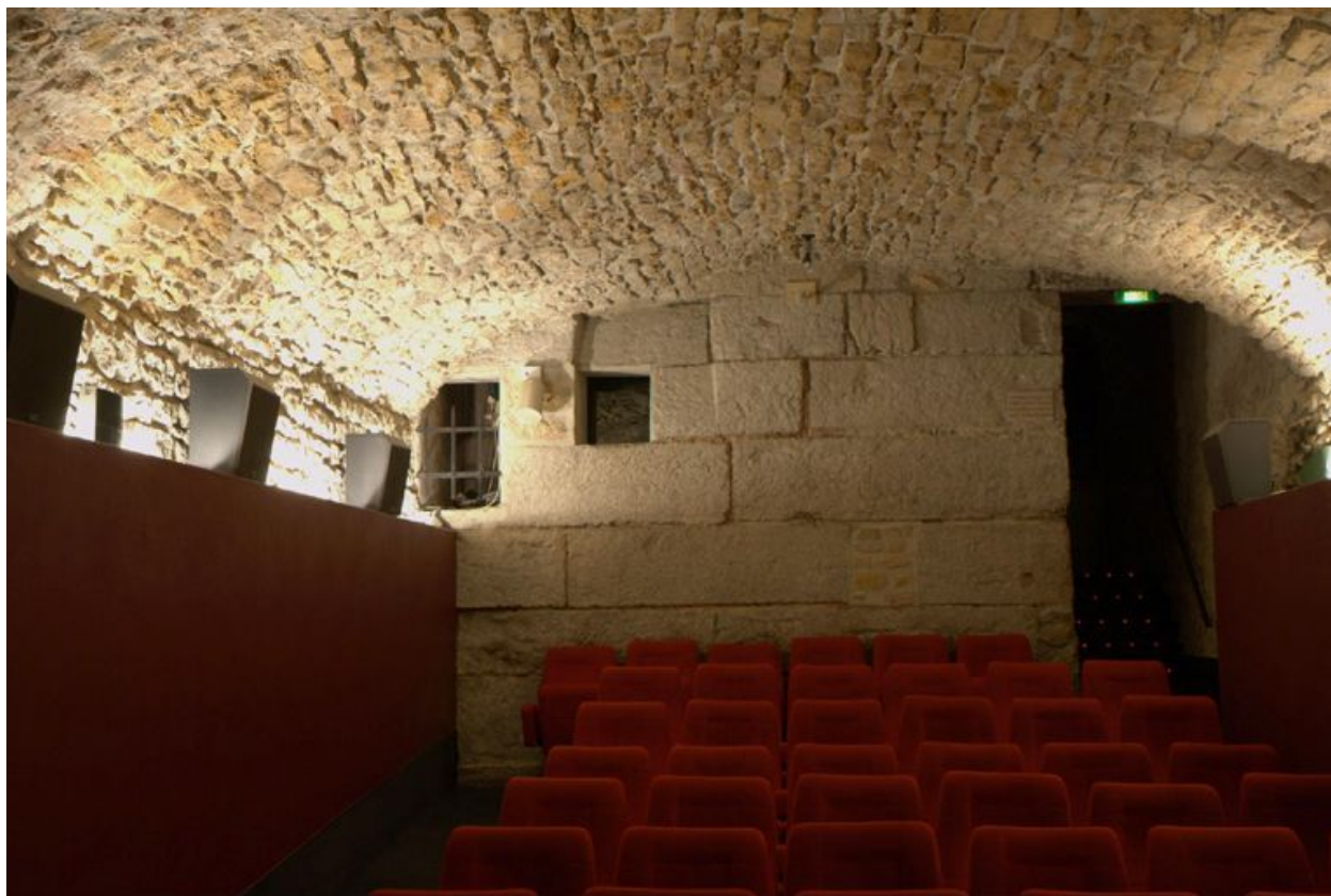
Sous-sol (actuelle salle 1 du cinéma), détail du mur de fondation
