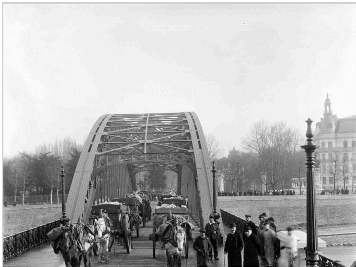
La construction du pont de la Boucle. L'épreuve de charge. [1903]. 1 fotogr. : n. et b. (AM Lyon. 15 Ph 1836)
