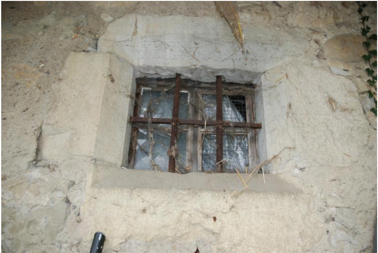
Maison, élévation sud : détail du jour de cave chanfreiné avec grille en fer forgé.
