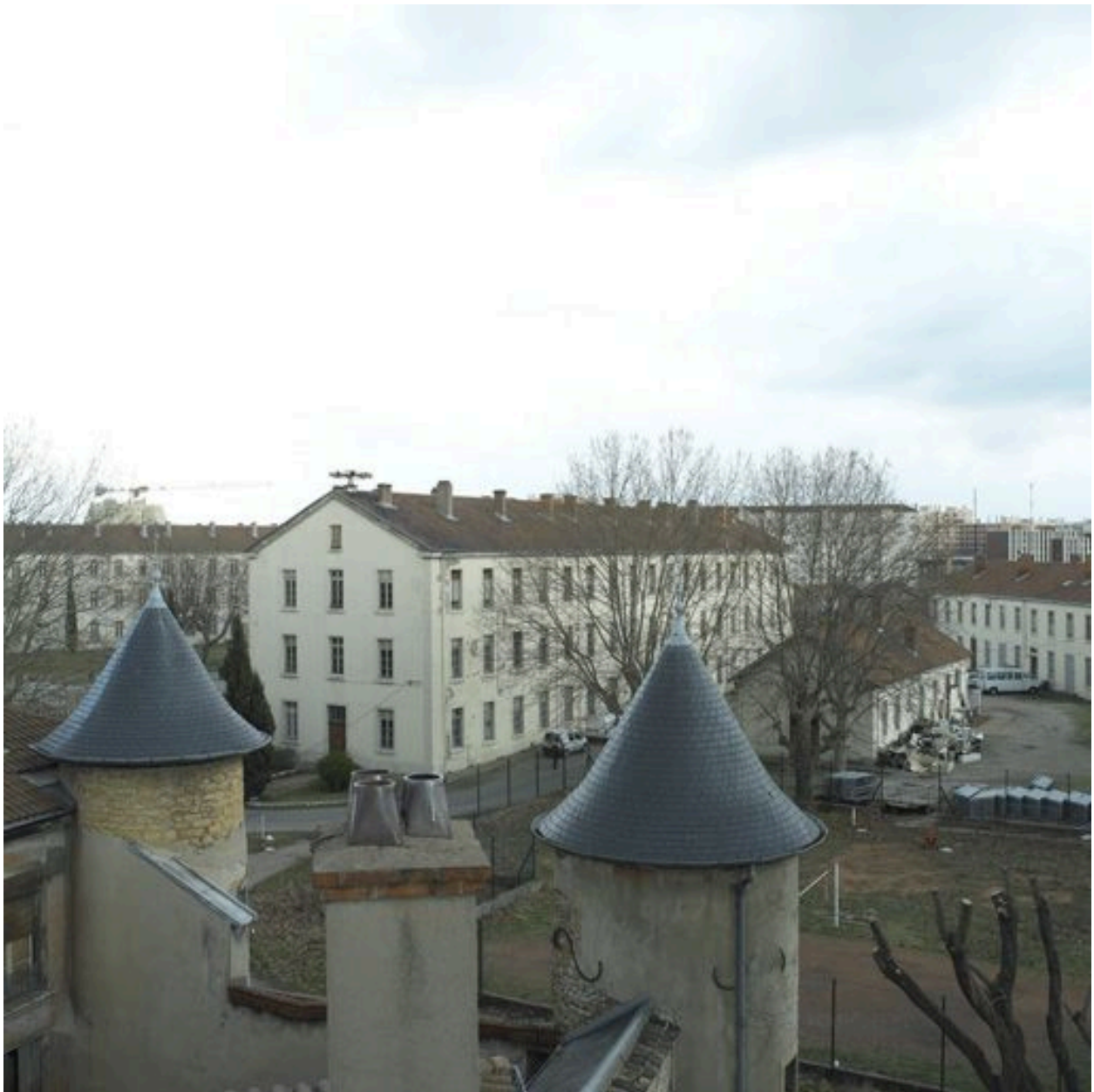
Corps de bâtiment est et tours est et sud-est. Vue des toits depuis le sud-ouest
