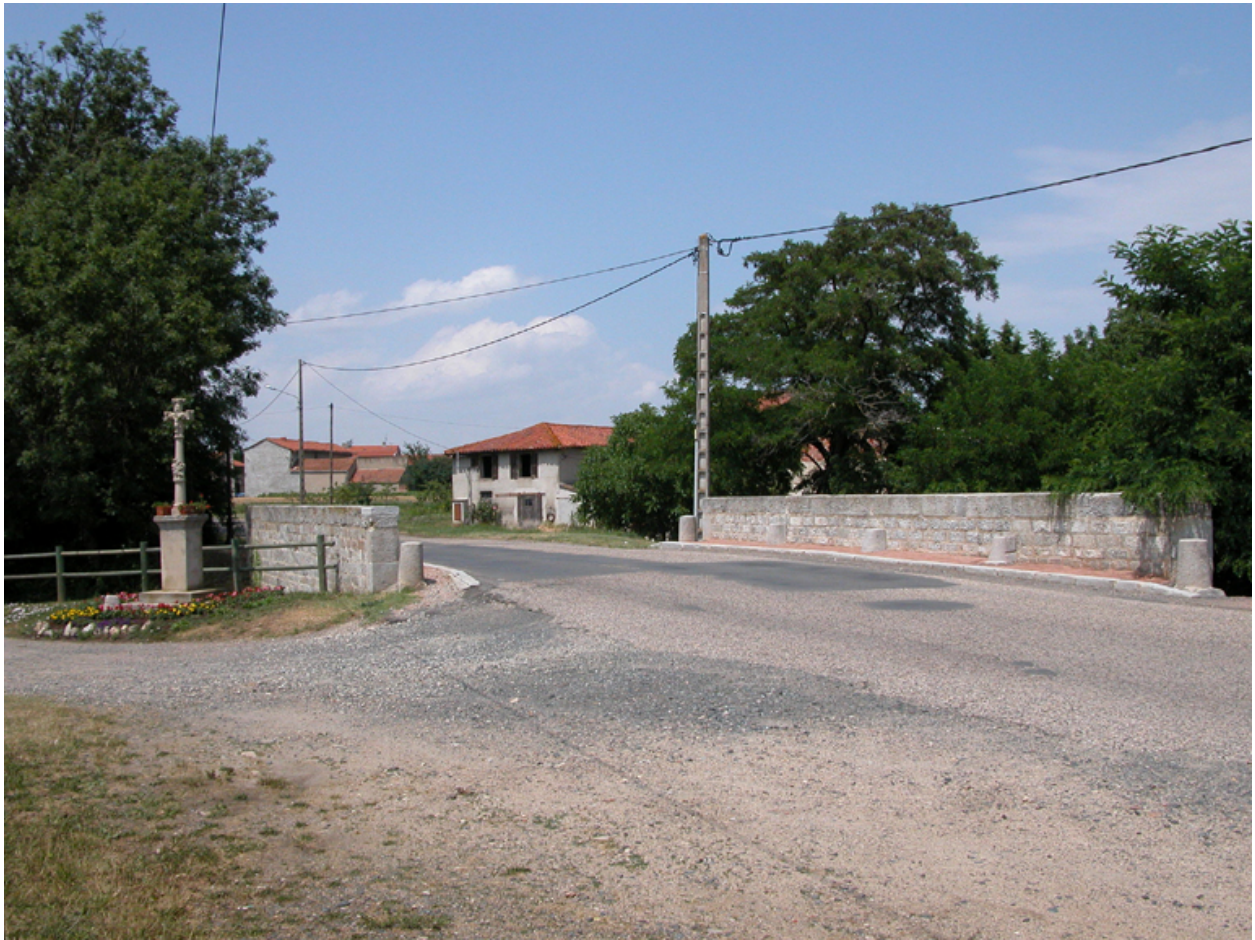
Vue générale (état actuel).
