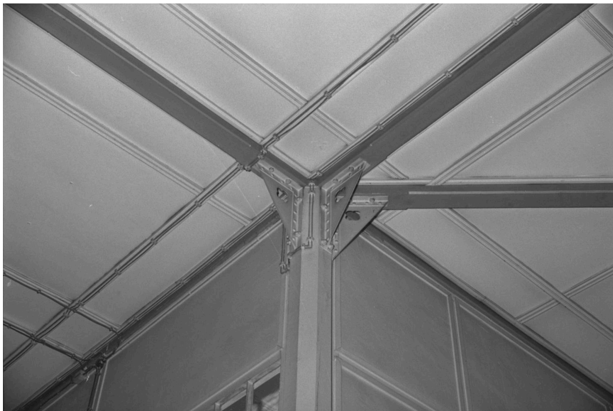
Poutre en chêne; console métallique. Pavillon EG, 3e étage, angle sud-ouest, extérieur de cloison d'escalier
