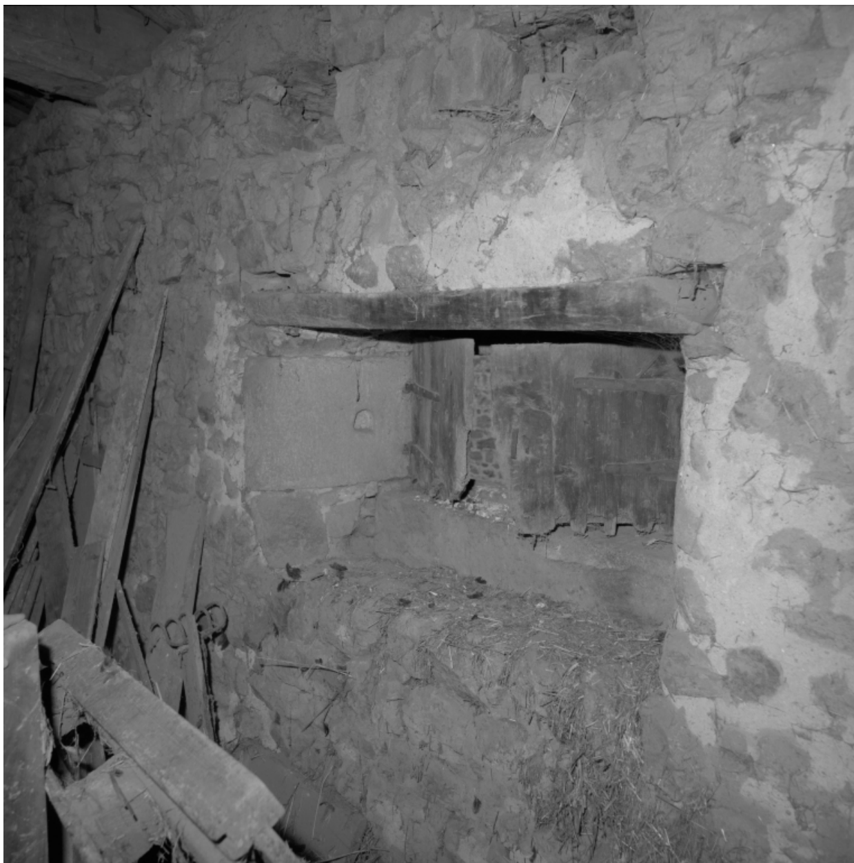
Premier étage, baie à meneau, avec volets en bois intérieurs fermés.
