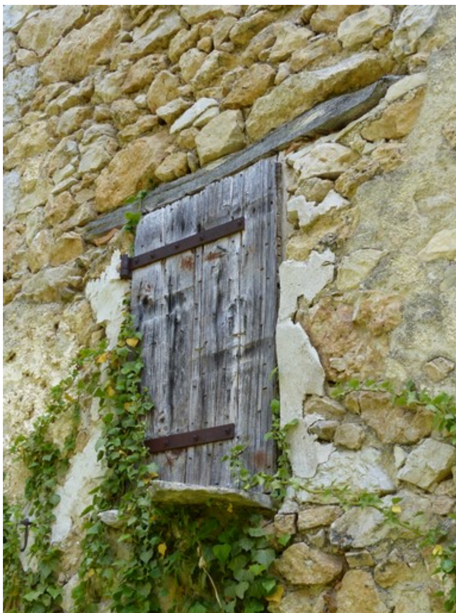
Pignon sud, deuxième niveau. Fenêtre de la cuisine.
