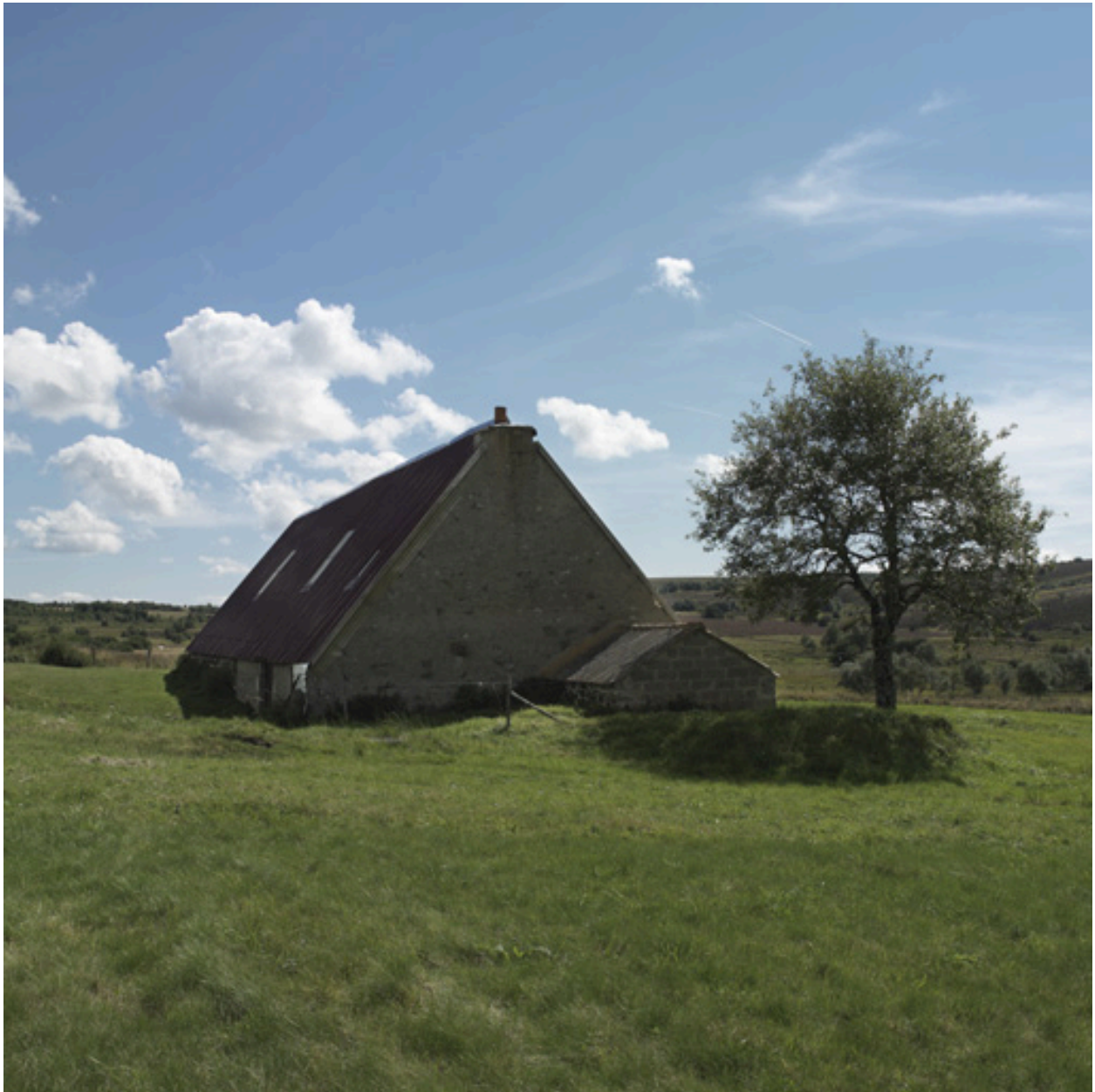
Vue latérale de la logette.
