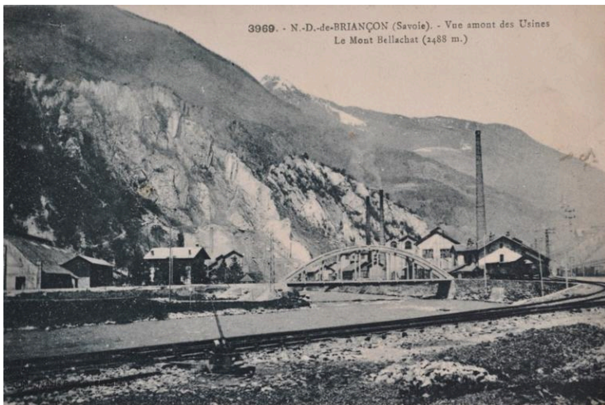
Vue des usines de Notre-Dame-de-Briançon (© Collection particulière M.-A. Podevin).
