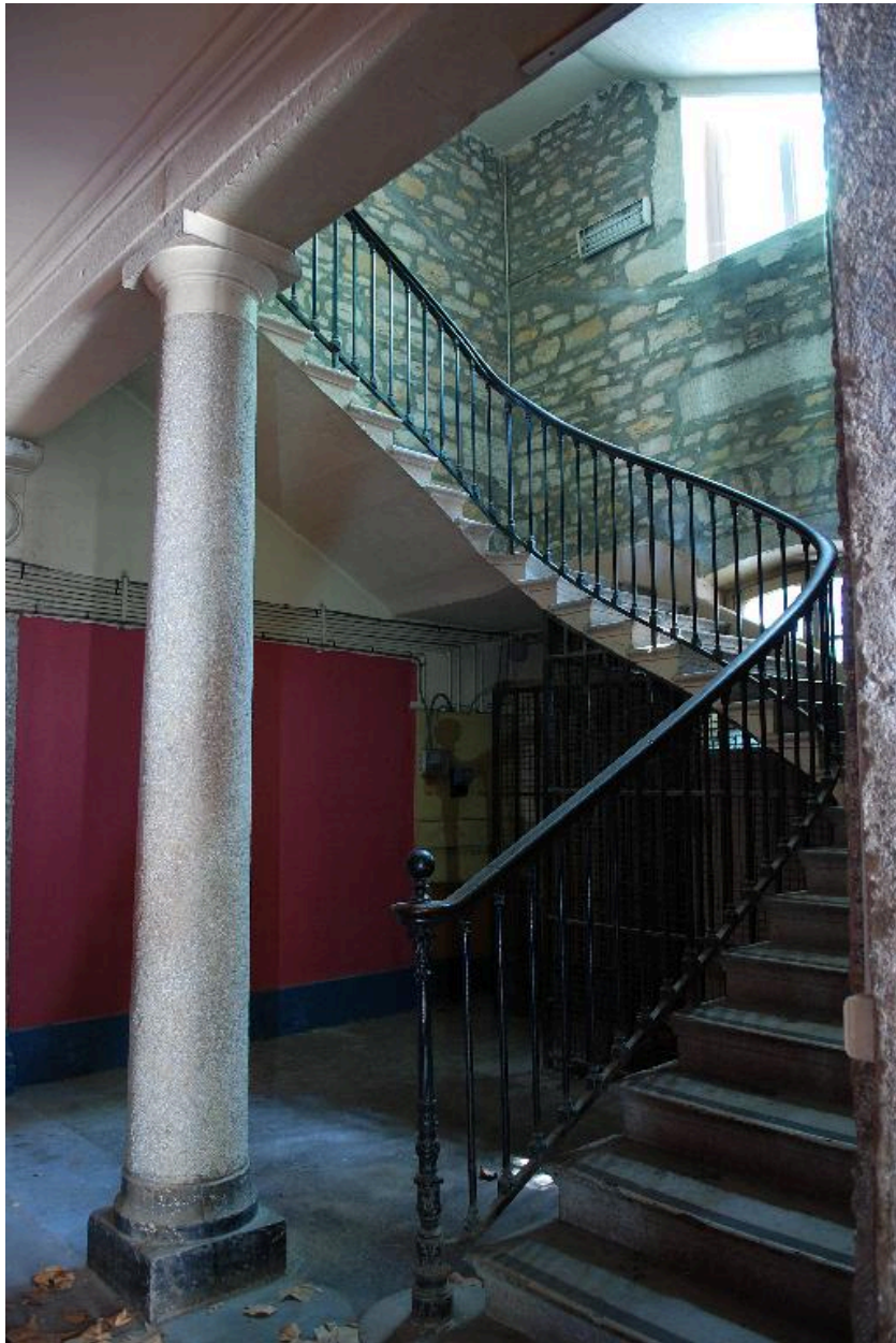
Etat en 2010 : le bâtiment d'administration, le départ et la cage d'escalier
