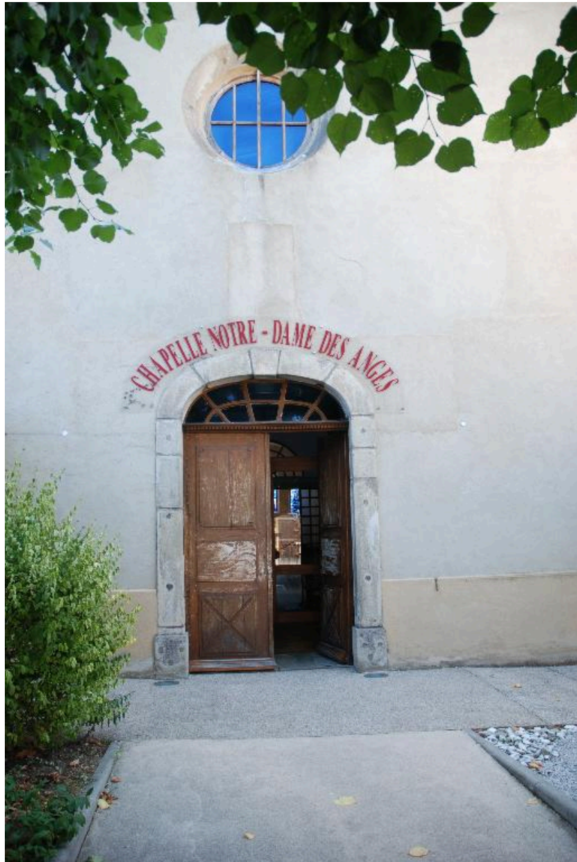
Vue sur l'entrée de la chapelle.
