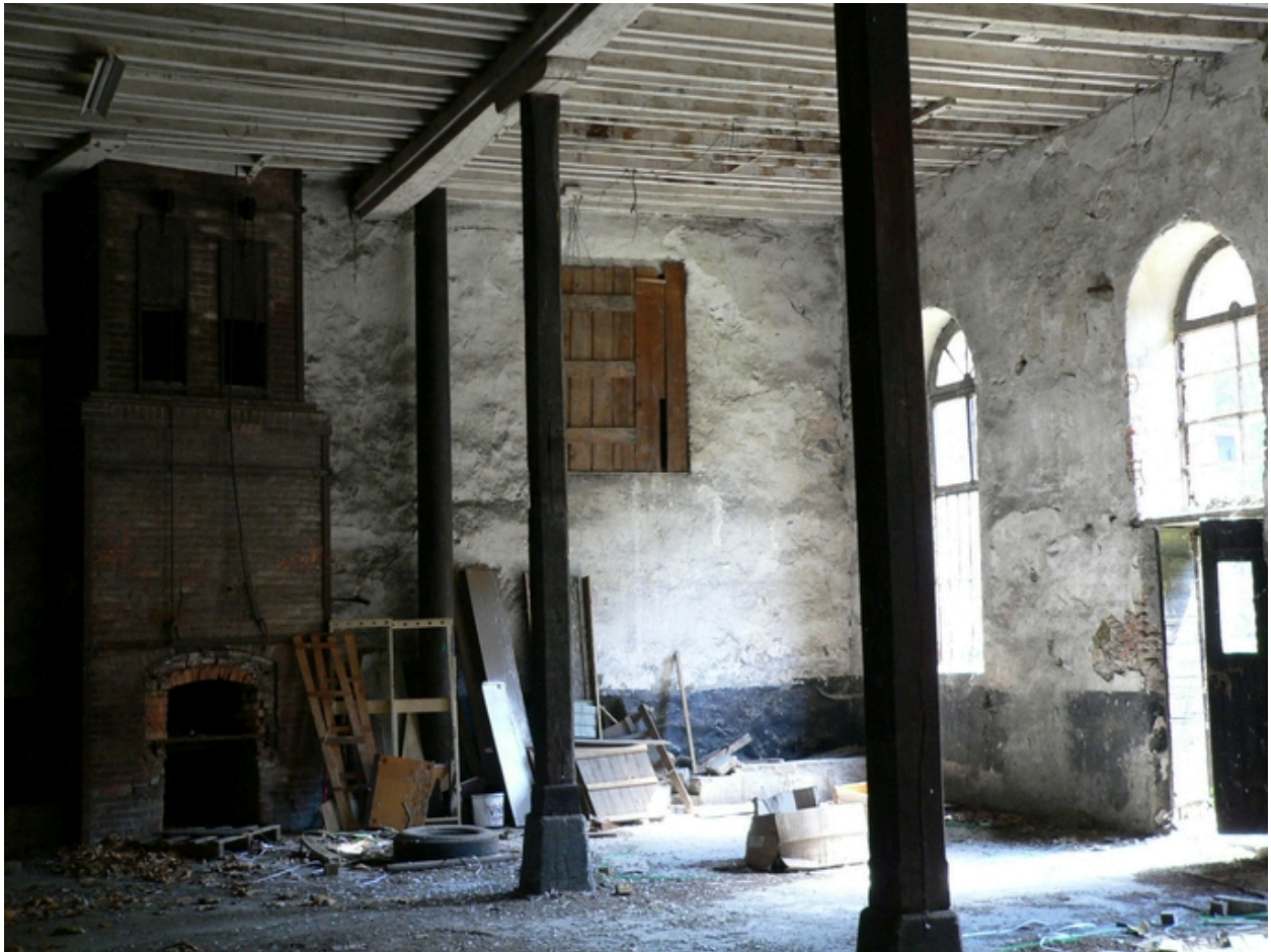
Rez-de-chaussée, four et baies sur Gère
