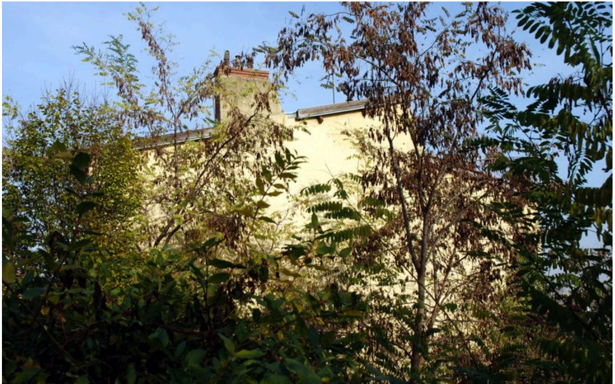
Détail du pignon.
