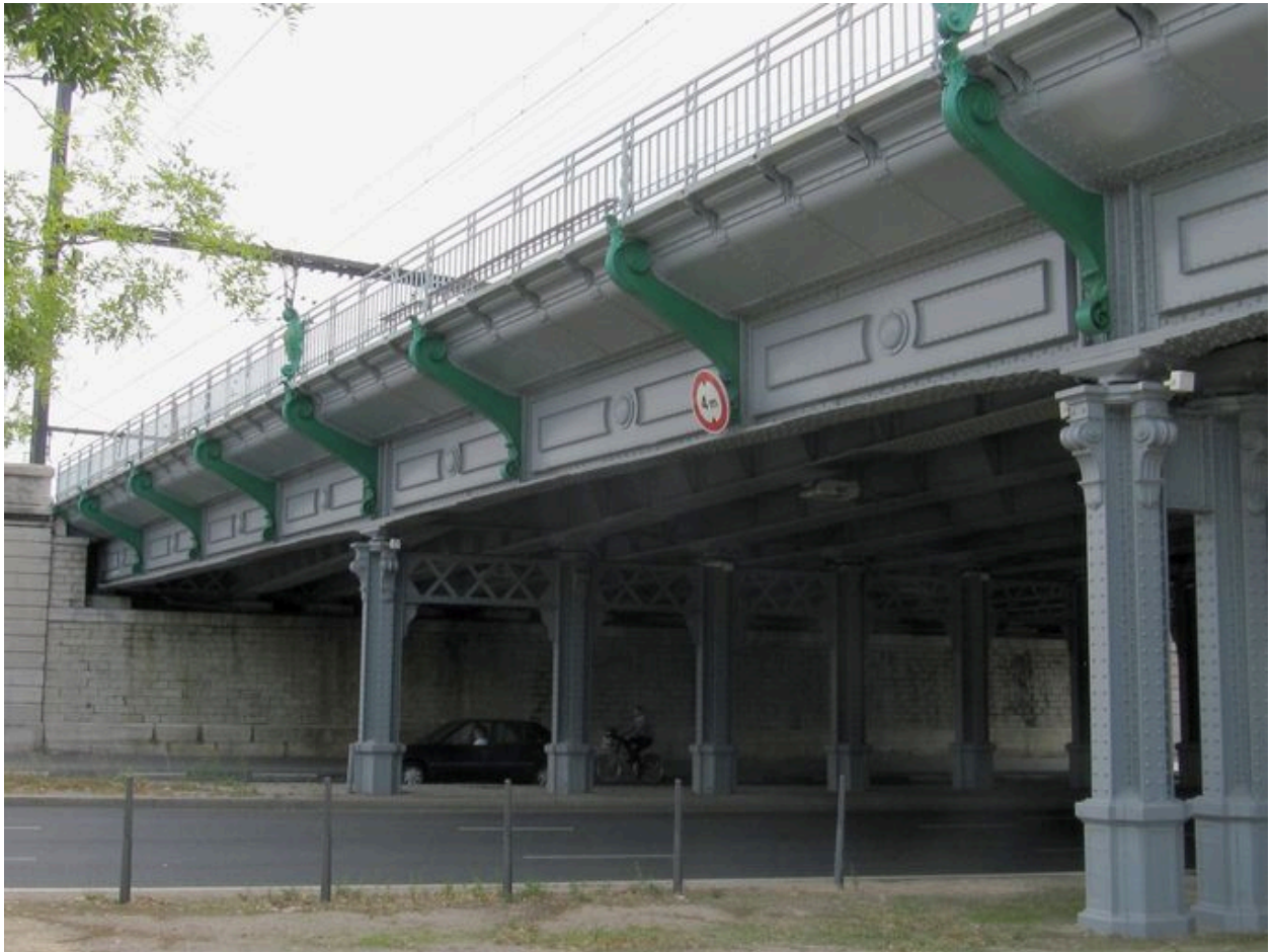
Travée de rive gauche, face amont, vue partielle : de côté (depuis la rive gauche)
