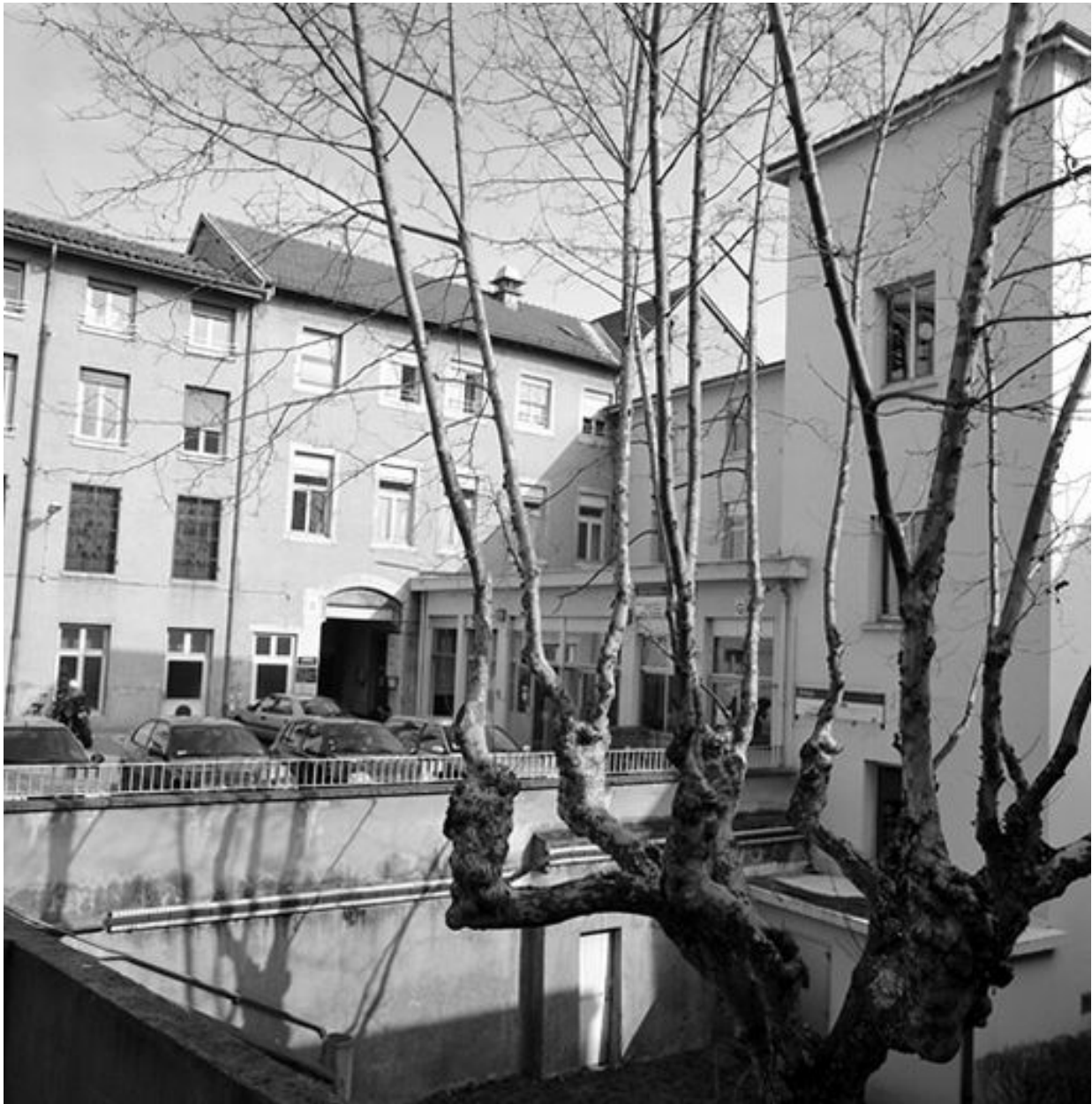
Angle de l'aile sud (5) et du bâtiment 7 sur la terrasse 10
