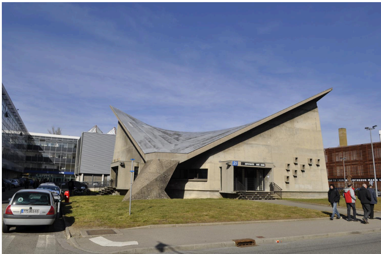
Vue de la toiture
