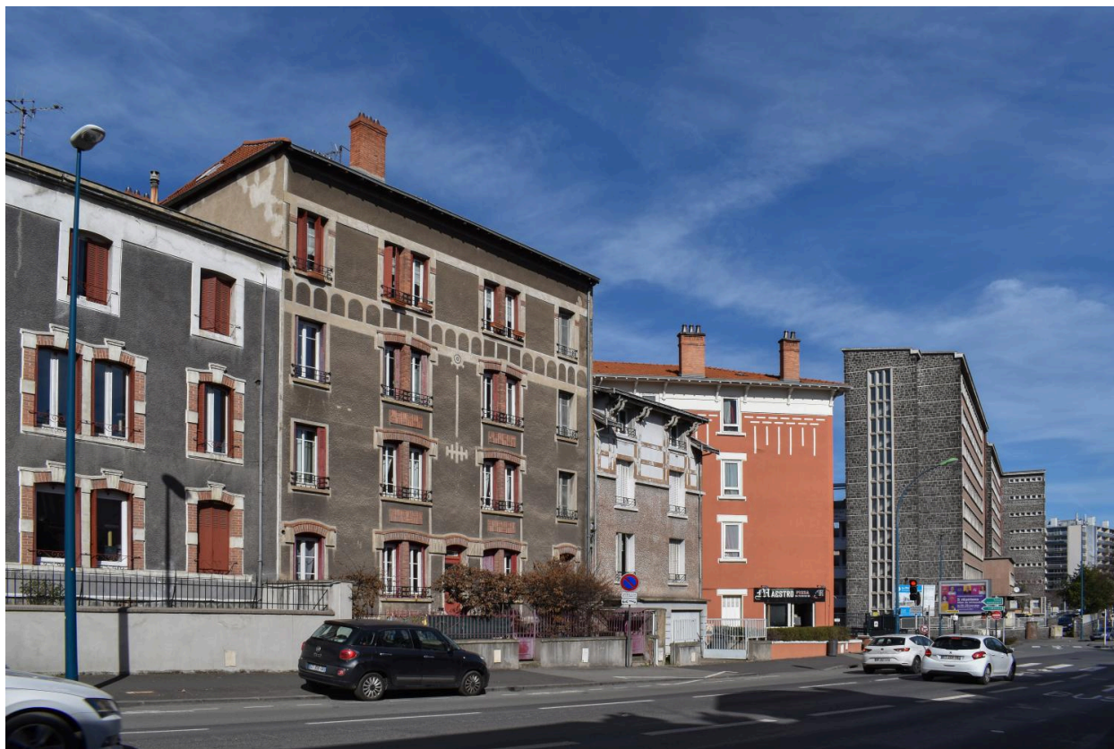
Elévations sur le boulevard Fleury (du 6 au 2)
