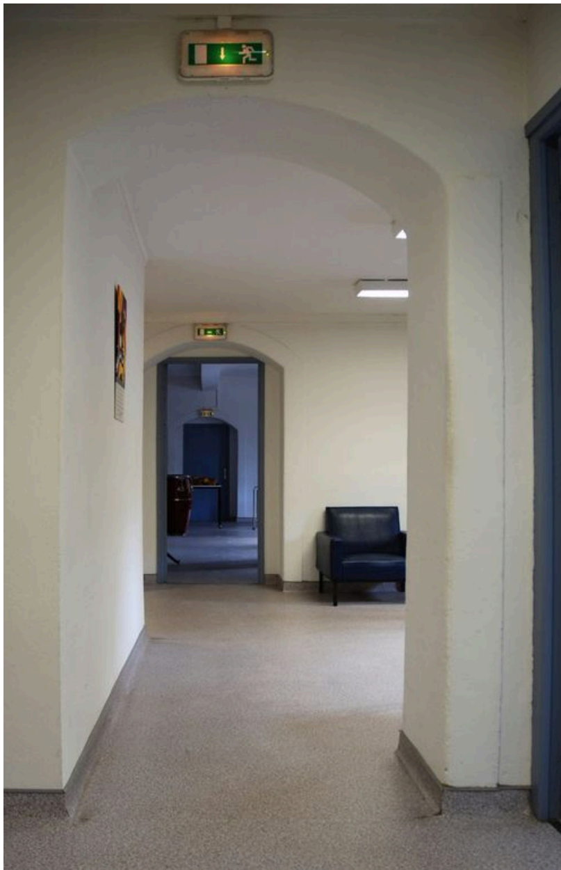
Etage de la boulangerie, ouverture
