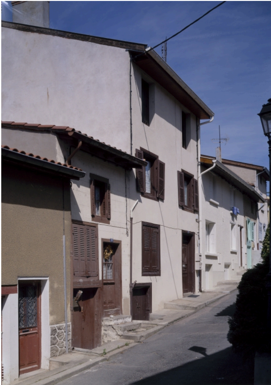
Vue des maisons de vigneron de la rue de la Garenne, du sud.
