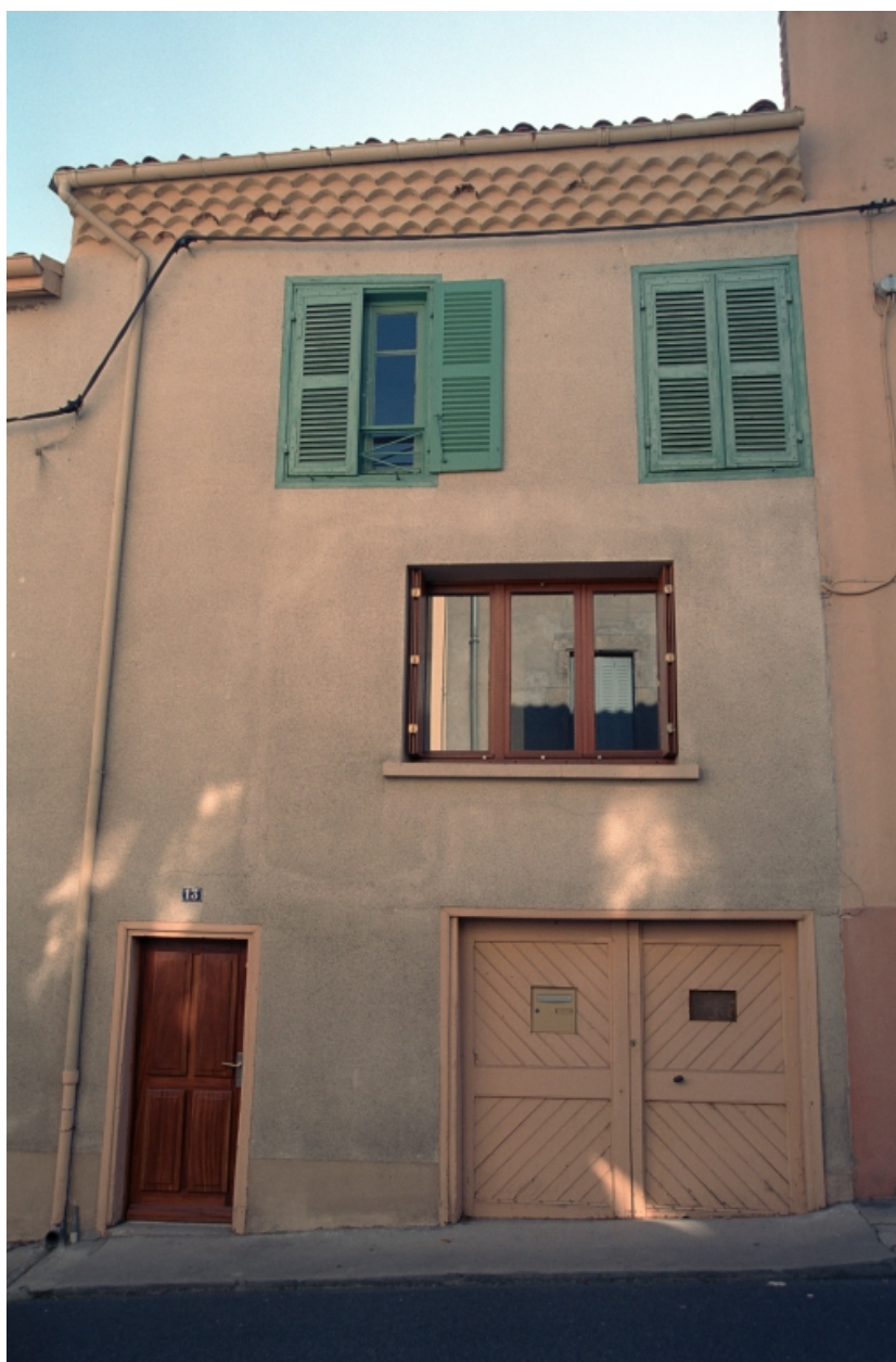
Boën, îlot 16, 8 Mai 1945 (rue du) 13. Vue générale de la façade sur rue.
