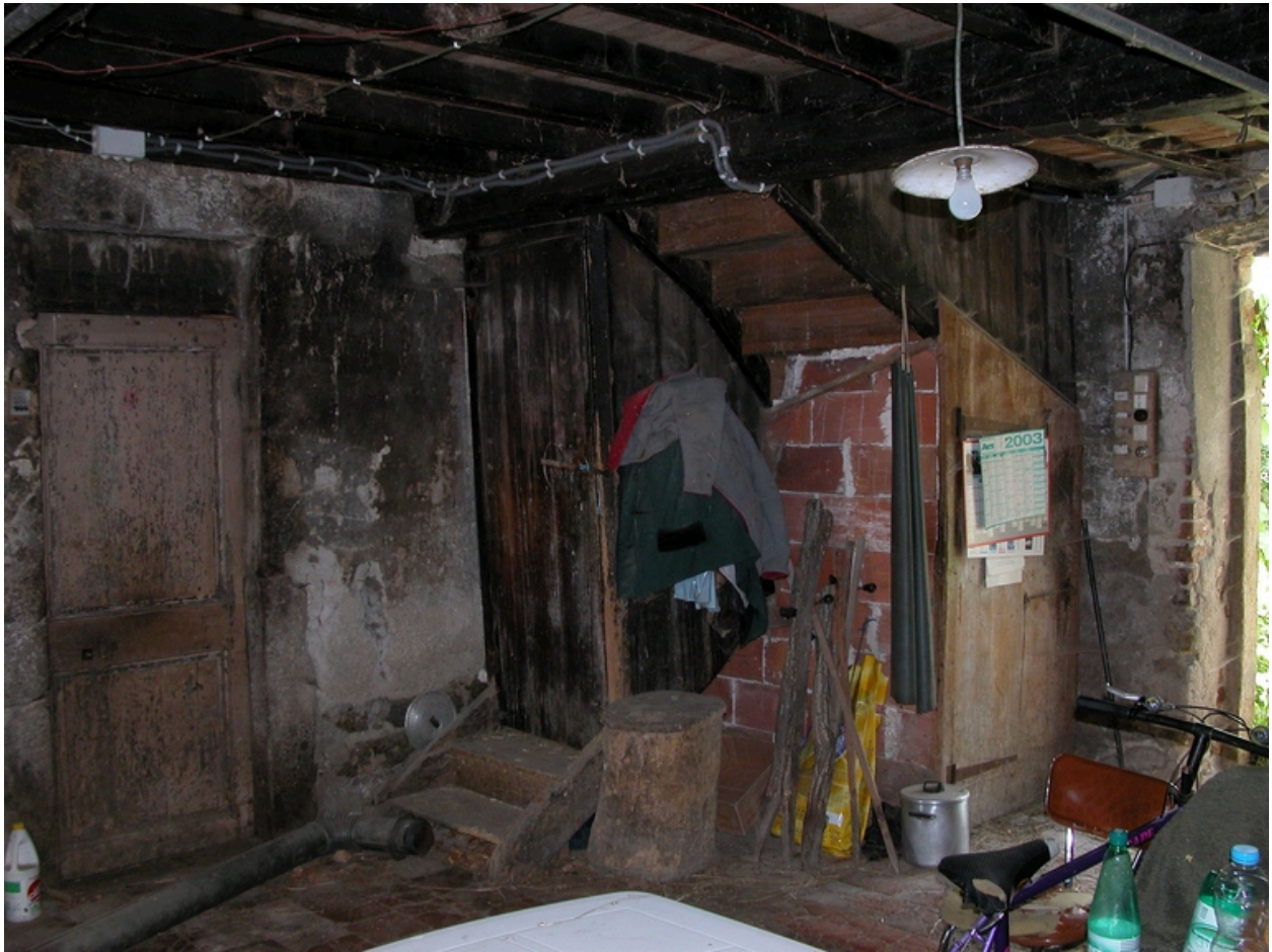
Vue intérieure de la cuisine : escalier, porte de communication avec l'étable.
