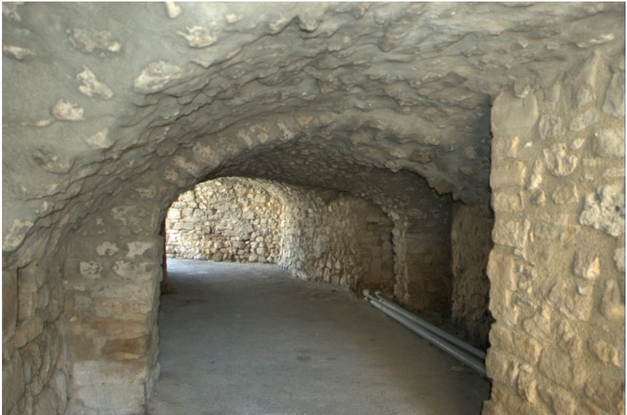
Passage couvert (soustet) passant sous l'ancien grenier à blé, vue prise depuis la rue basse.
