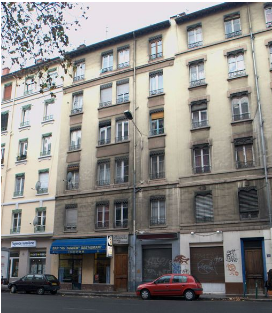
Elévation principale depuis le nord-est
