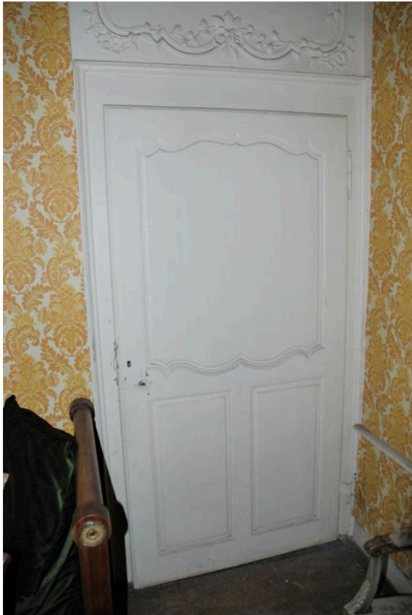
Corps principal, rez-de-chaussée, partie nord, salon (Cf. Plan RDC 2), porte de placard nord.
