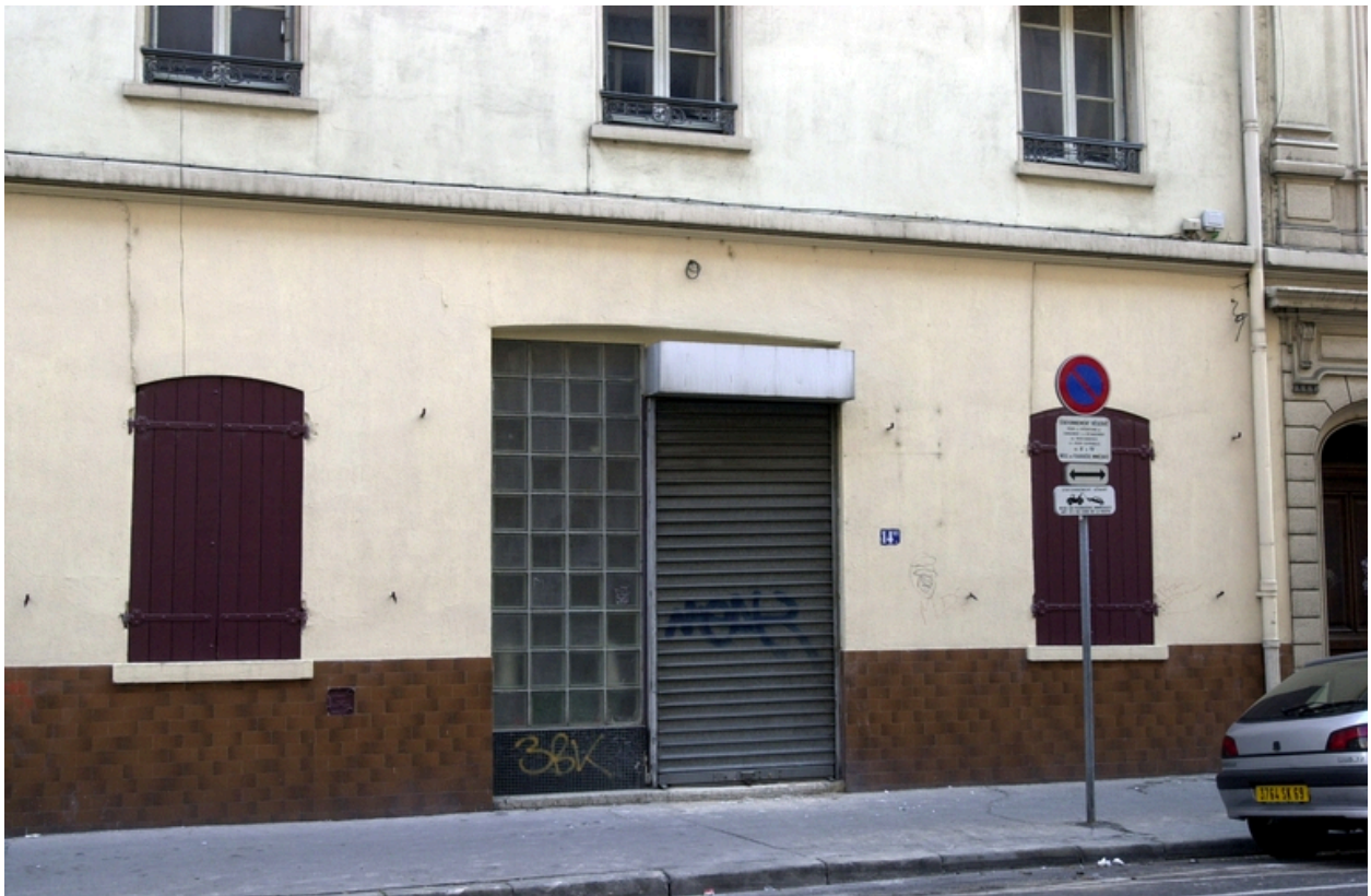
Vue du rez-de-chaussée
