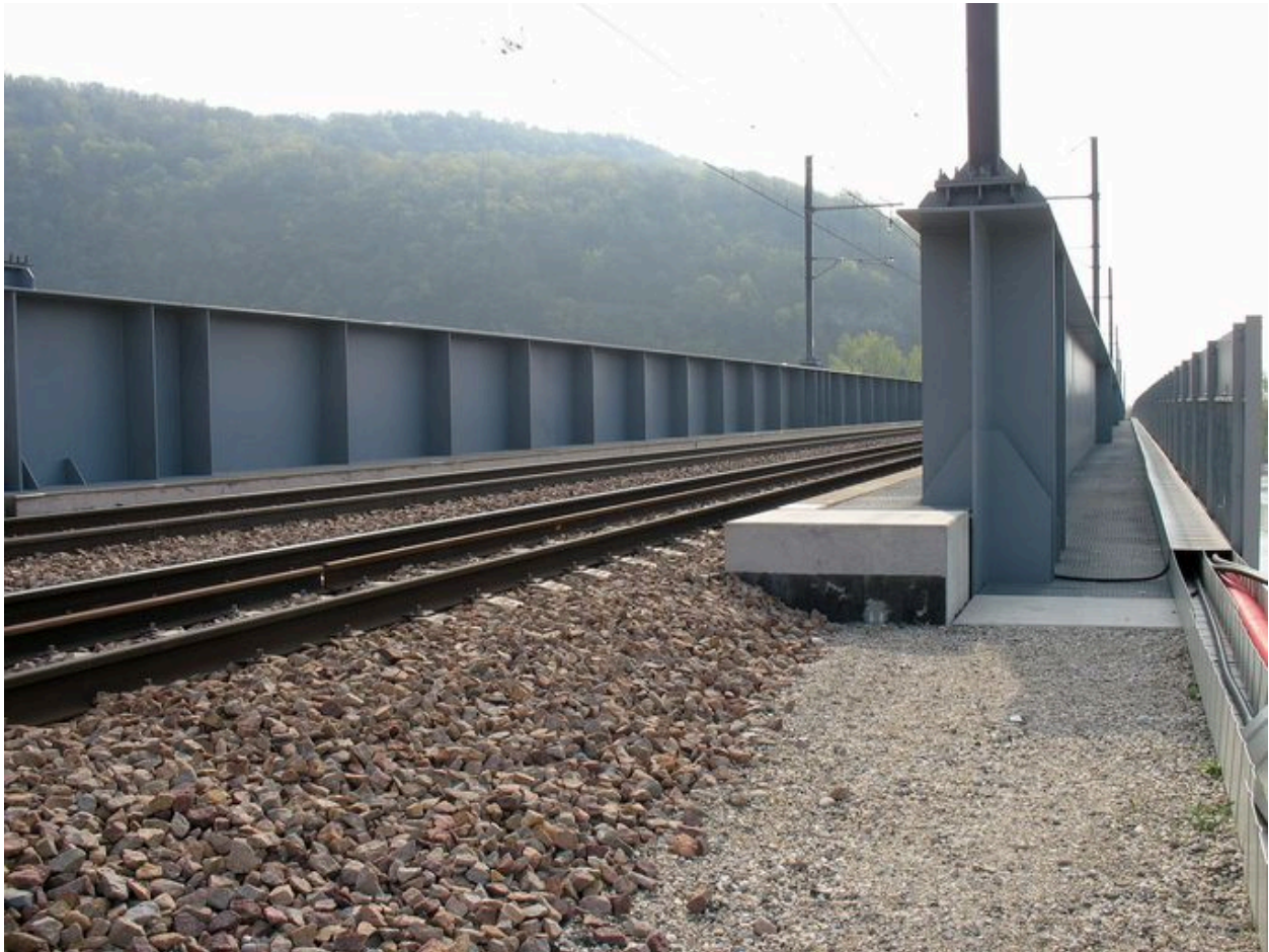
Vue sur le tablier : voie ferrée
